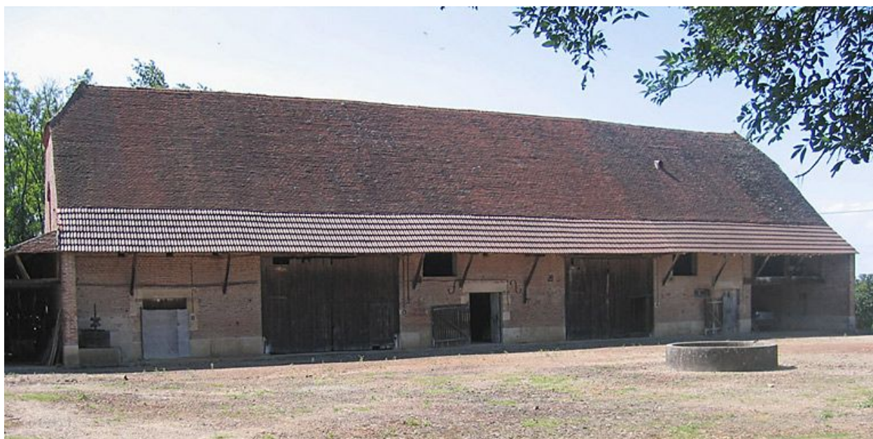
Vue d'ensemble de la façade.
