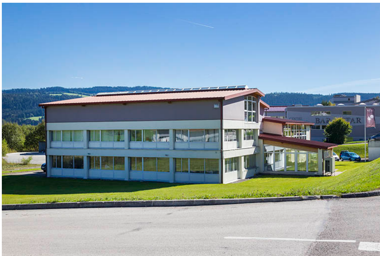
Façades postérieure et latérale gauche.
