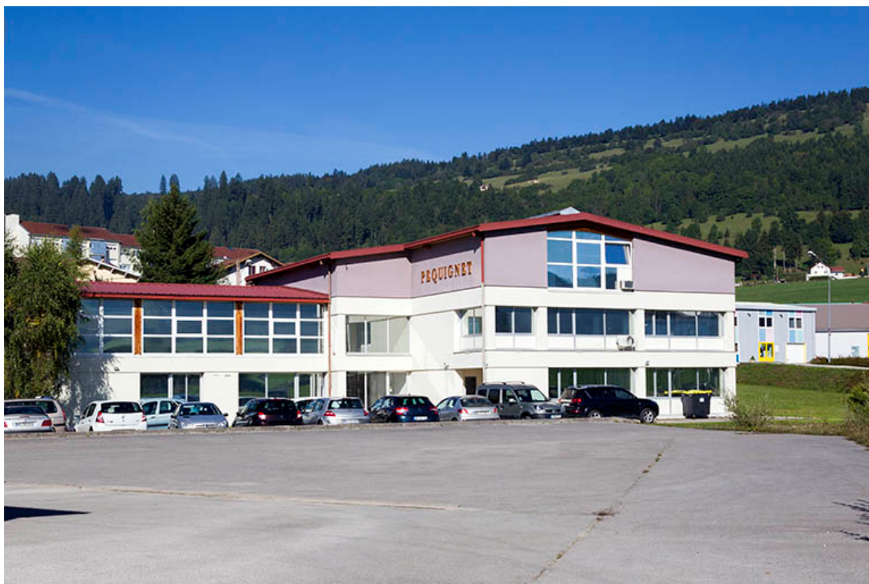
Façade latérale droite, de trois quarts gauche.
