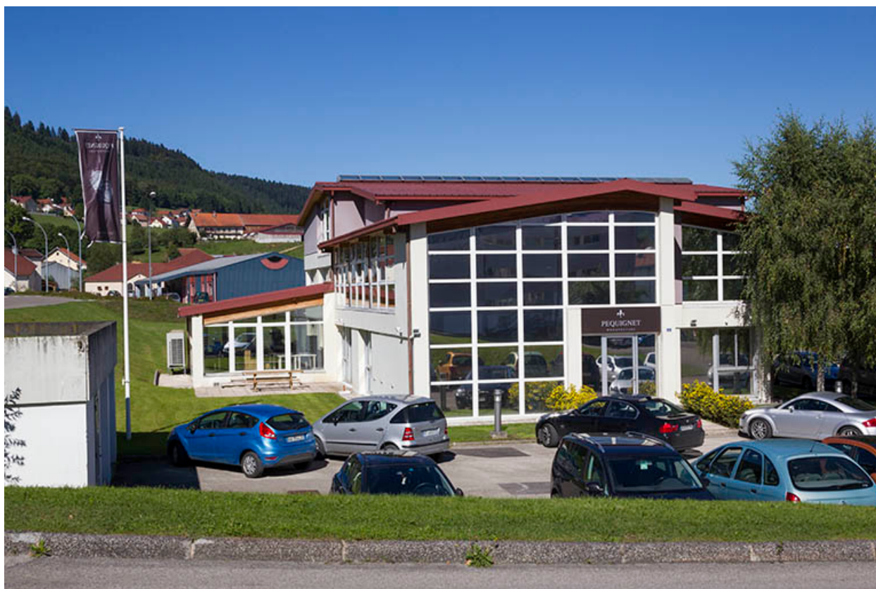
Vue d'ensemble, depuis le sud (façade antérieure).
