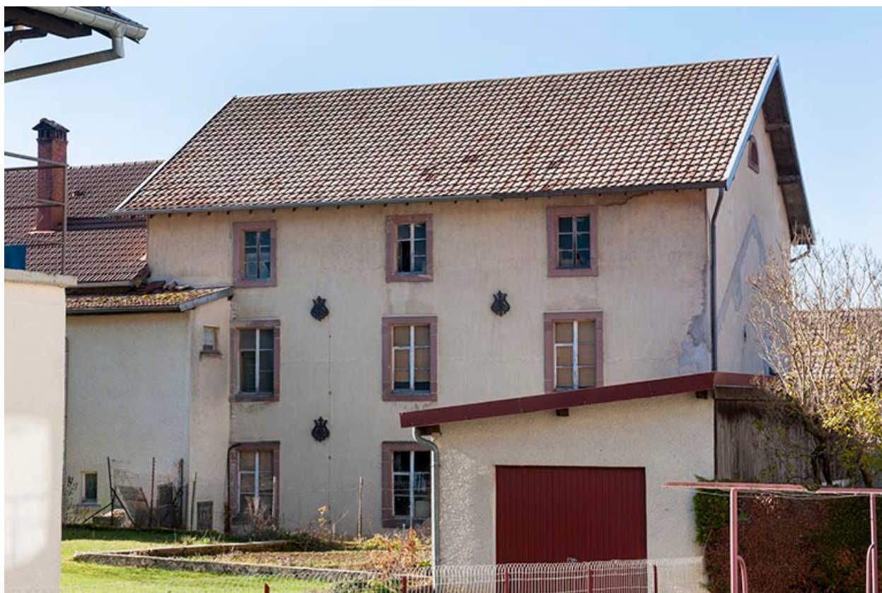
Minoterie : façade postérieure.
