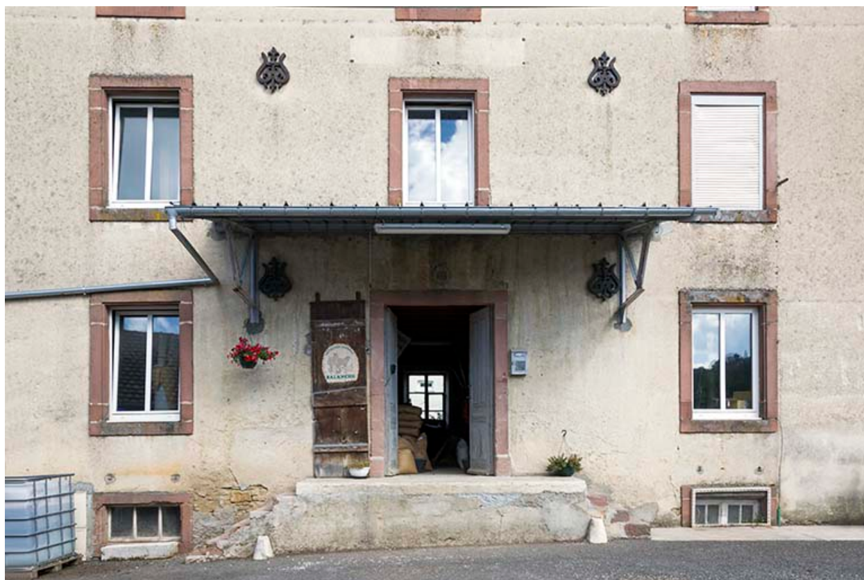
Minoterie : partie centrale de la façade antérieure.
