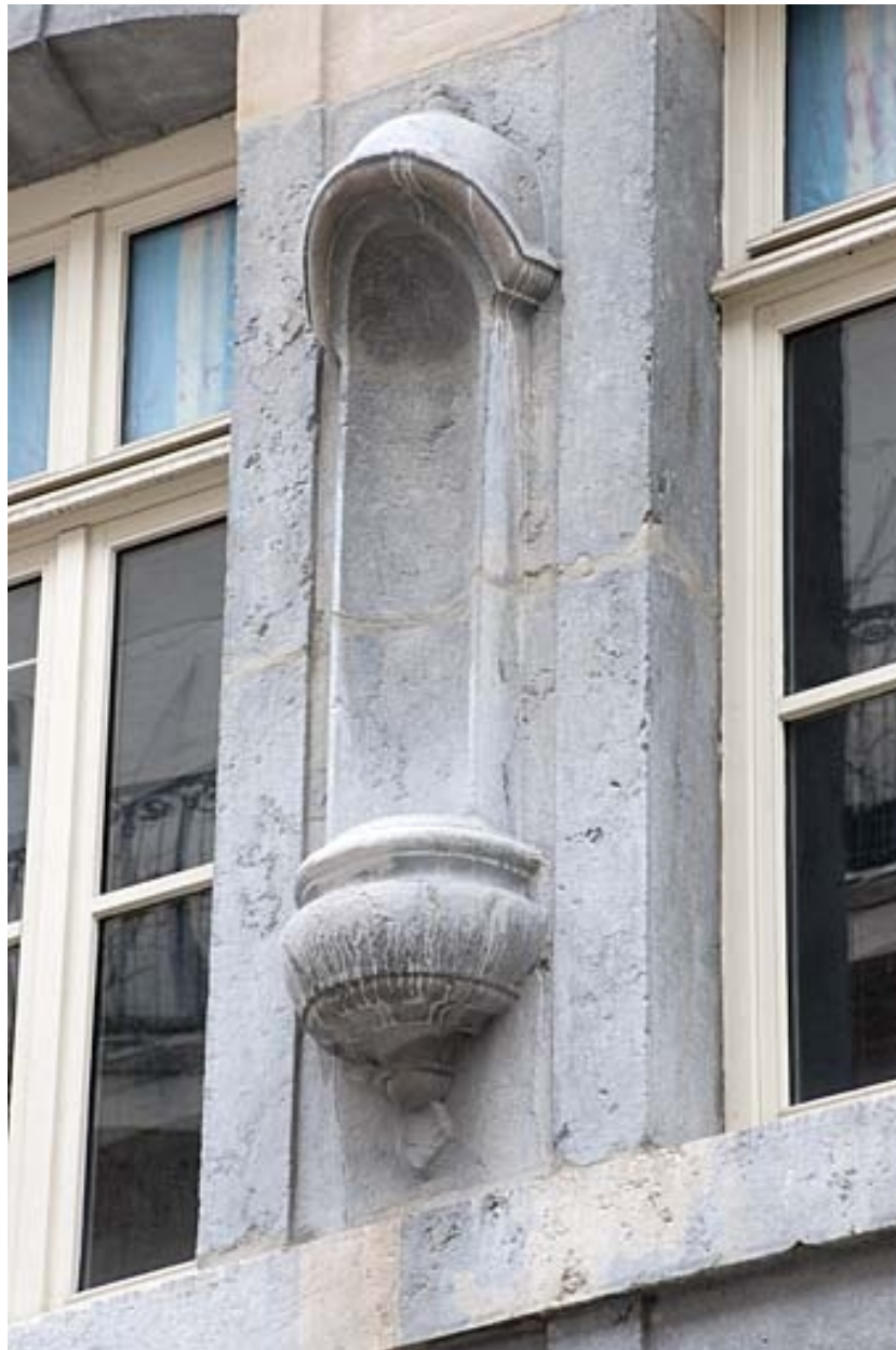
Façade sur rue : détail de la niche.
