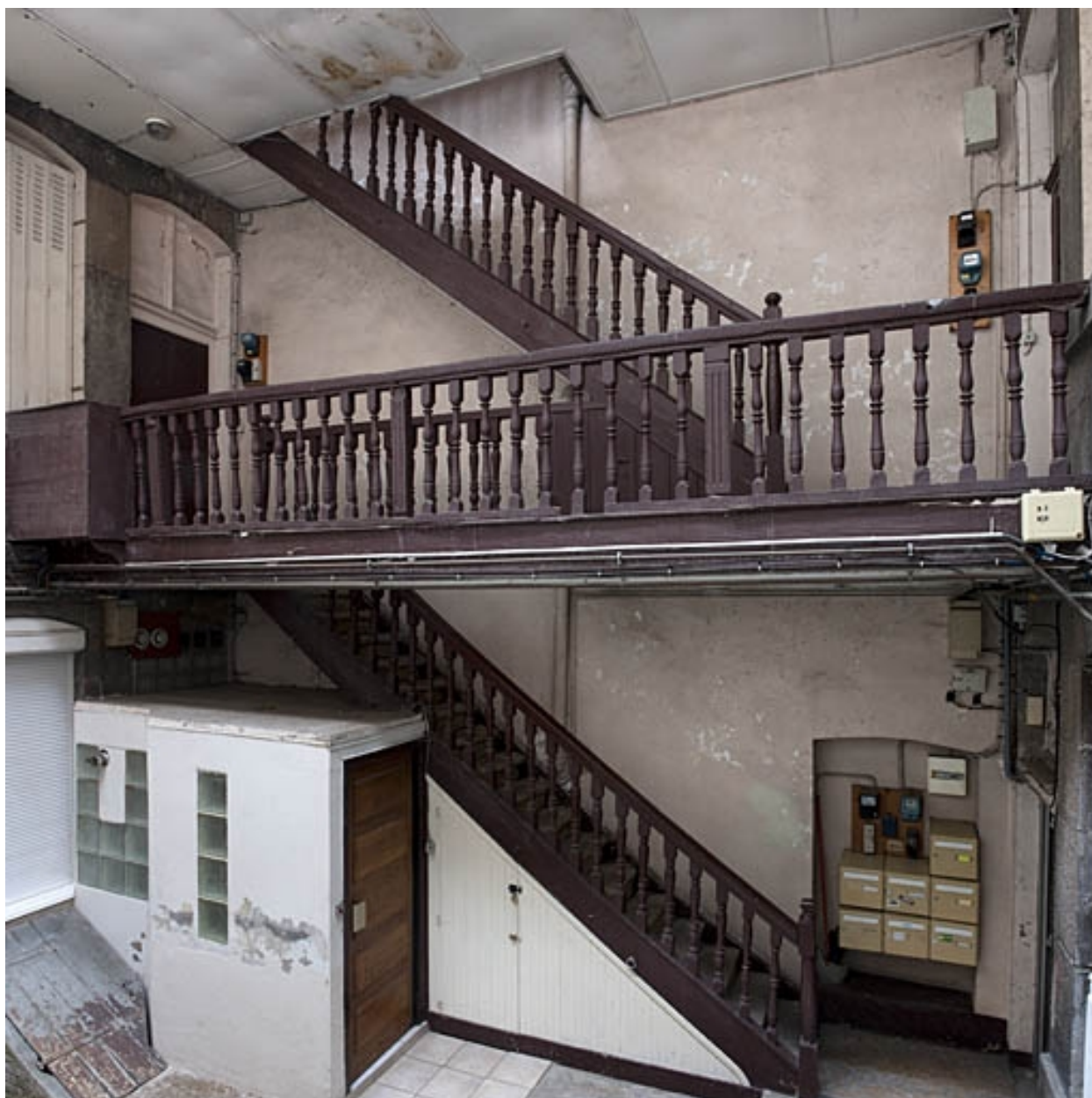
Vue d'ensemble de l'escalier à cage ouverte.
