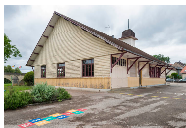
Vue depuis le fond de la cour. Phot. Jérôme Mongreville IVR43_20177001122NUC4A
