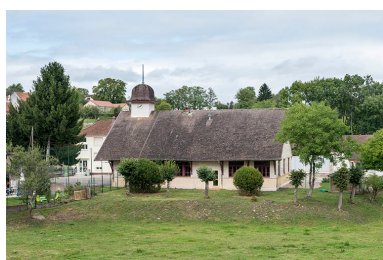
Vue depuis le pont. Phot. Jérôme Mongreville IVR43_20177001118NUC4A
