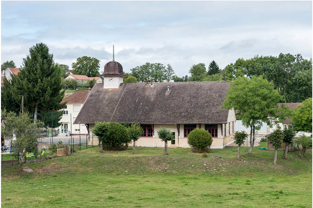
Vue depuis le pont.
