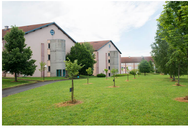
Les pignons sud-ouest de l'externat d'enseignement scientifique avec leurs cages d'escaliers en béton. Phot. Mary Ruffinoni IVR43_20137000472NUC4A
