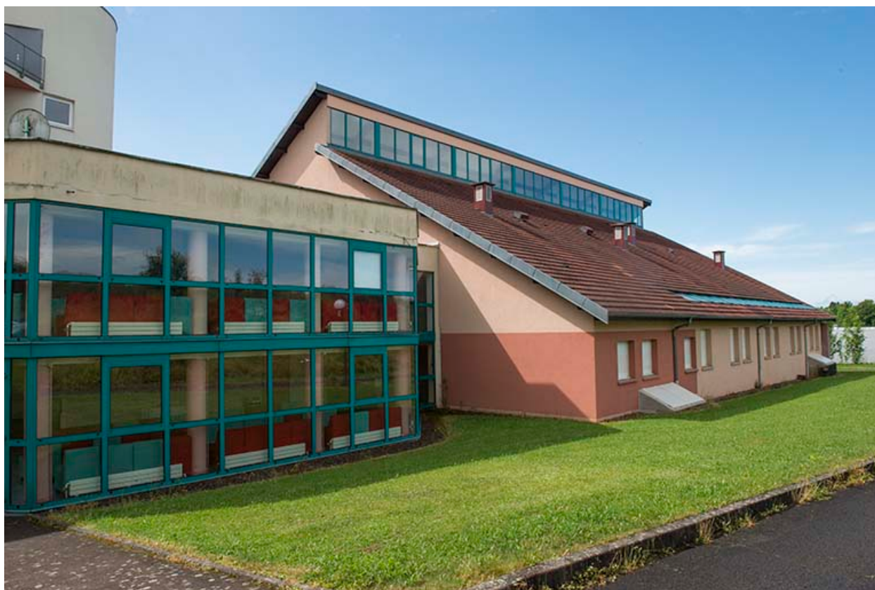
Façades postérieures nord de l'internat sud-ouest.
