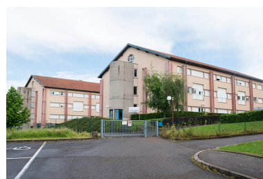
Les pignons sud-ouest de l'externat avec leurs cages d'escaliers en béton. Phot. Mary Ruffinoni IVR43_20137000466NUC4A
