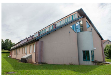
Pignon ouest de l'internat sud-ouest. Phot. Mary Ruffinoni IVR43_20137000474NUC4A
