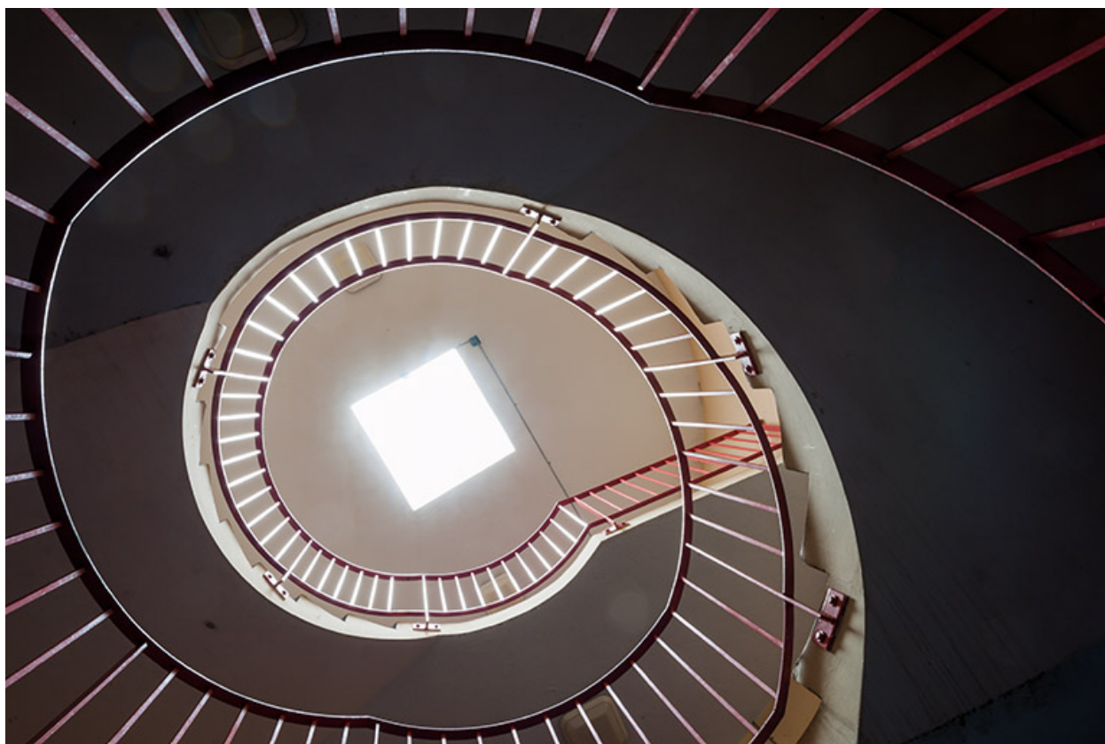
Escalier en vis en béton de l'internat.
