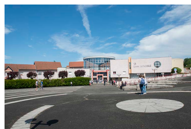
Façade de l'entrée. Phot. Mary Ruffinoni IVR43_20137000482NUC4A
