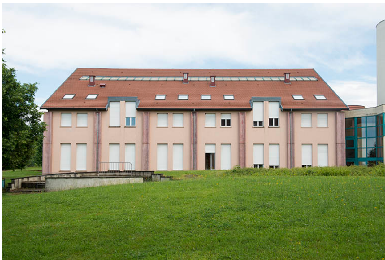
Façade antérieure sud de l'internat sud-ouest.
