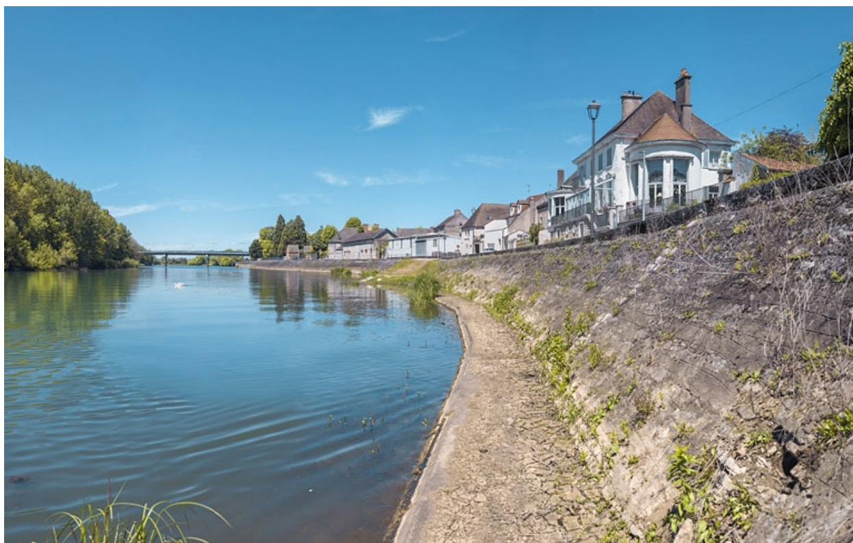
Quais en aval du pont routier.
