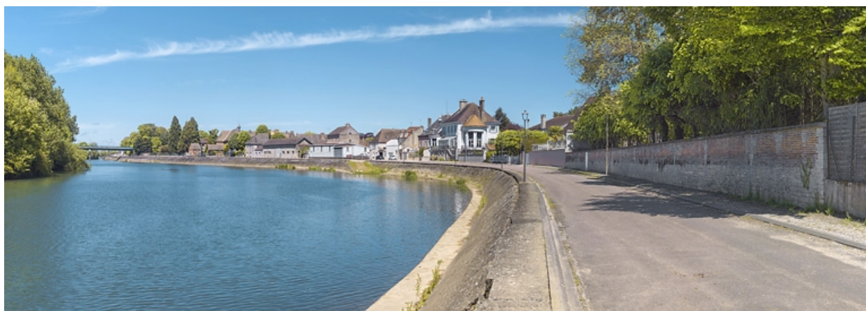
Panorama des quais en aval du pont.
