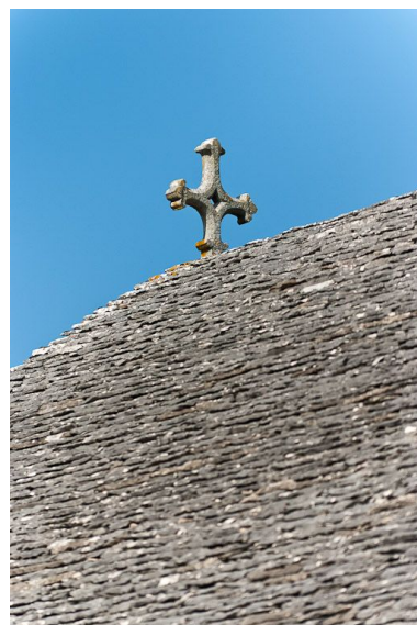
Détail de la toiture.
