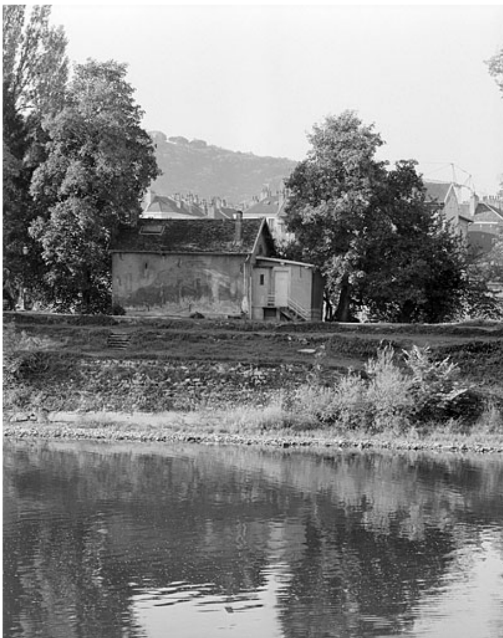
Façade antérieure en 2003, avant restauration.
