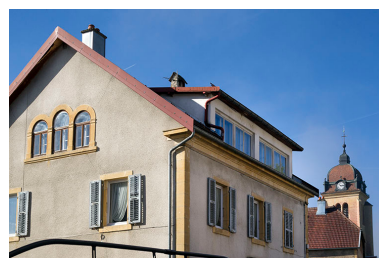
Etage et étage en surcroît (côté est). Phot. Yves Sancey IVR43_20132502098NUC2A
