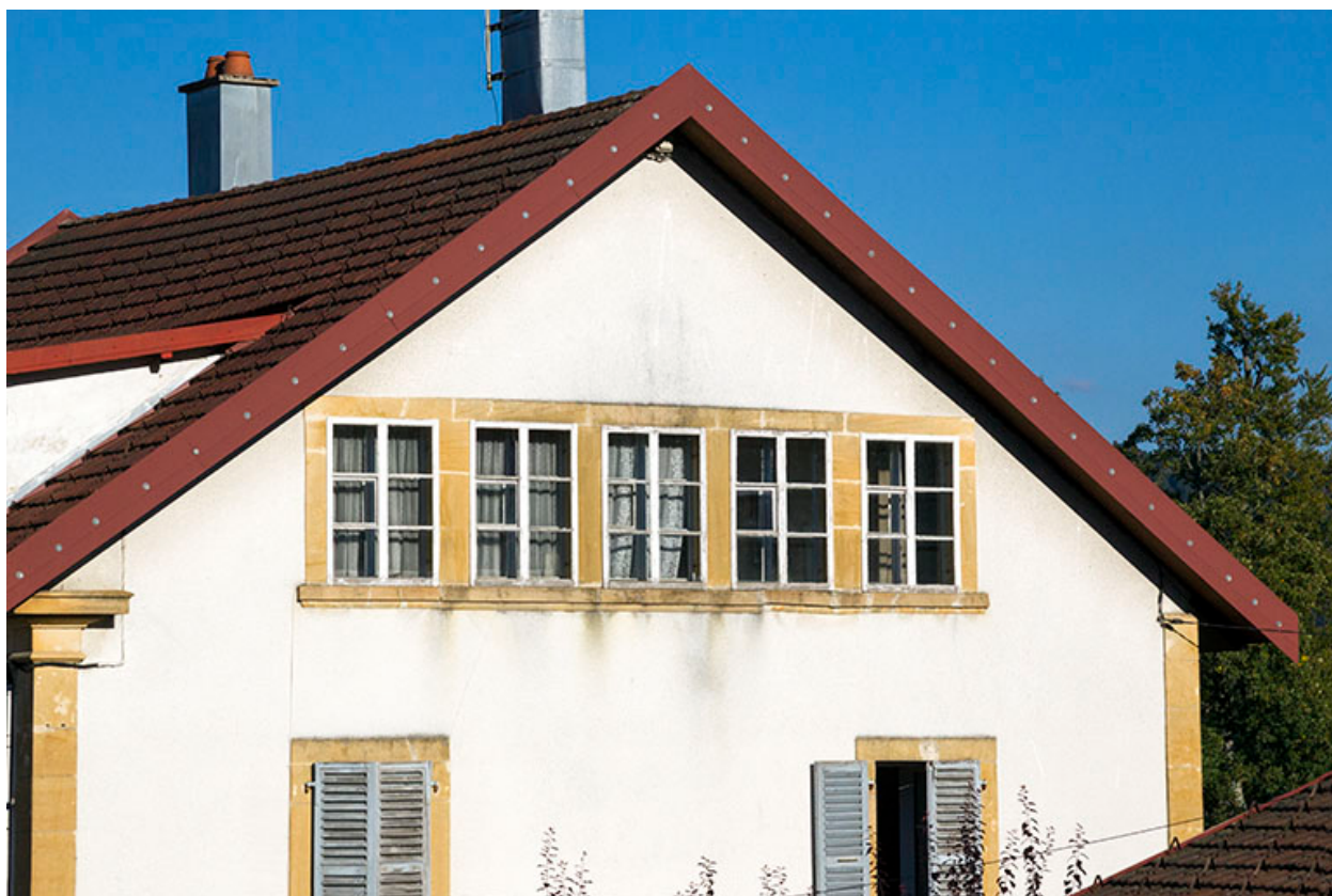
Pignon occidental : fenêtres multiples.
