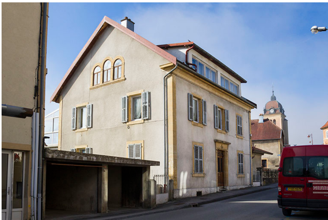
Façades antérieure et latérale gauche.
