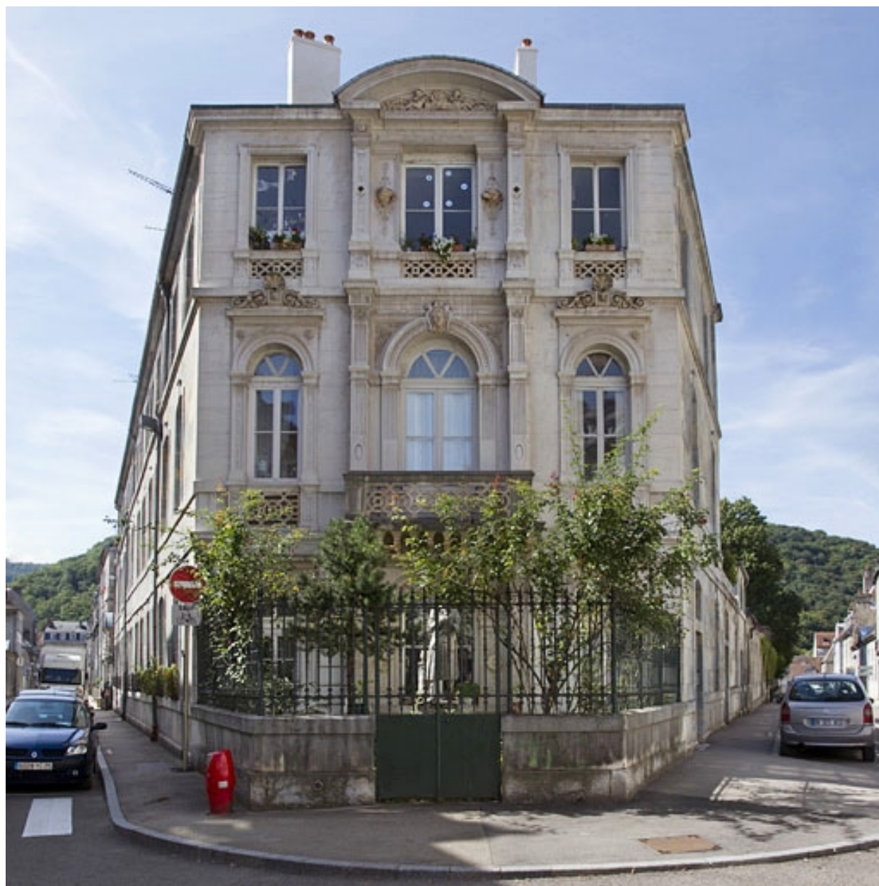
Façade d'angle : de face.
