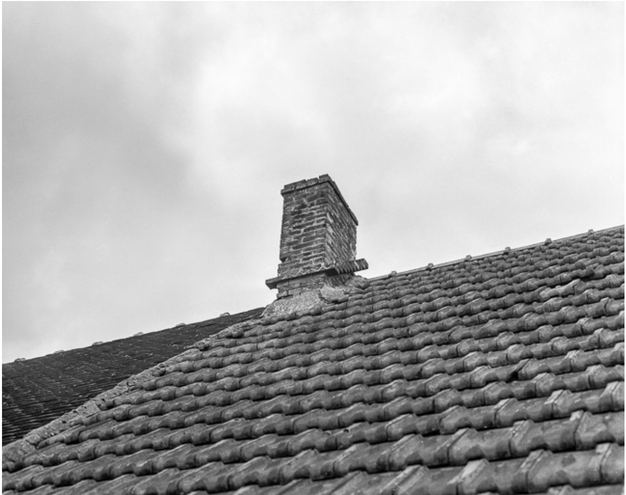
Vue du toit et de la cheminée.
