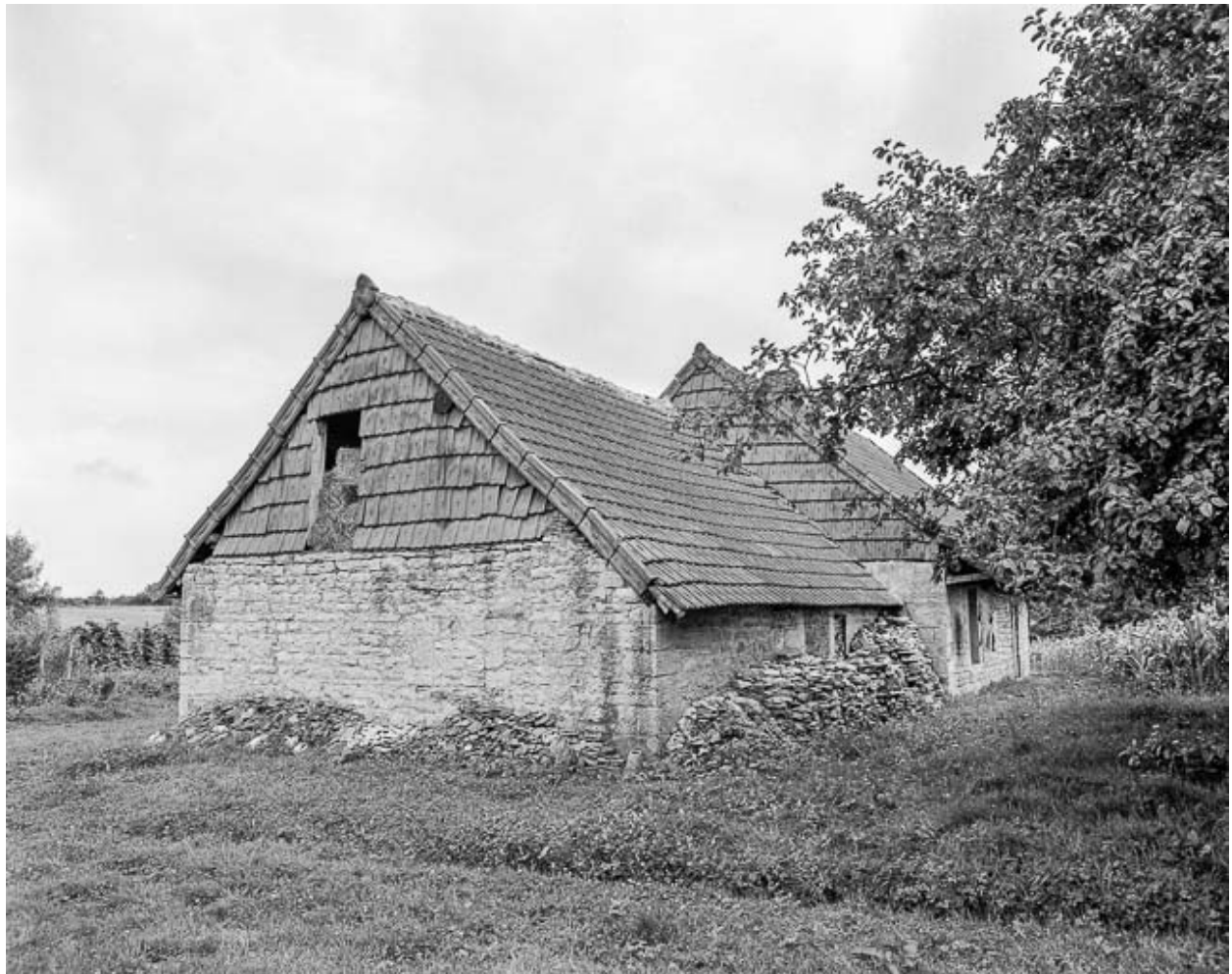
Façade postérieure et pignon droit.
