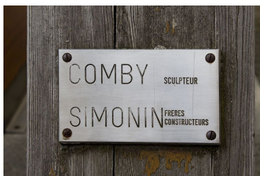
Eléments en lamellé- collé : inscription donnant l'auteur et le fabricant. Phot. Yves Sancey IVR43_20122500733NUC2A
