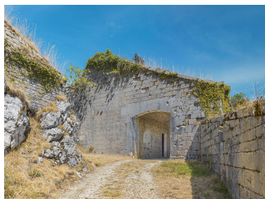
Façade postérieure. Phot. Thierry Kuntz IVR43_20223901124NUC4A
