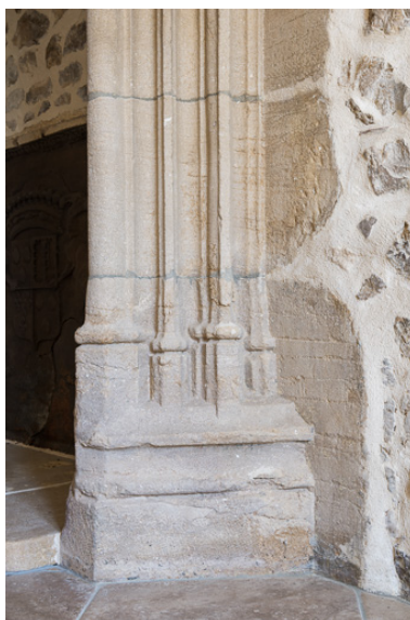
Détail de la cheminée : piédroit avec bases à moulures prismatiques Phot. Pierre-Marie Barbe-Richaud IVR26_20197100272NUC4A
