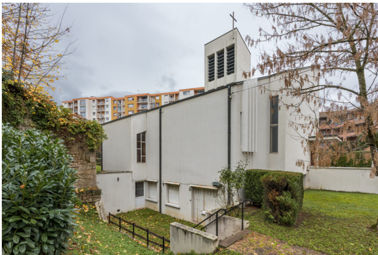
Vue de la façade sud (de trois-quarts).
