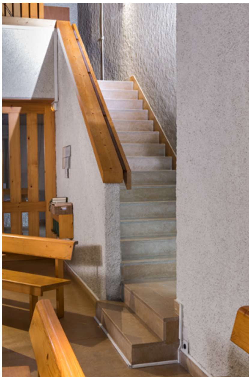
Vue de l'escalier de la tribune.
