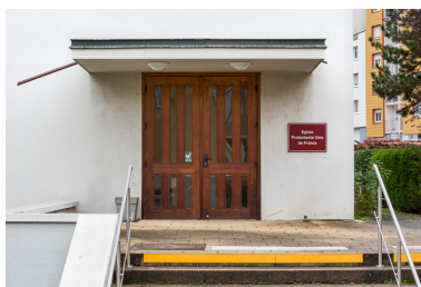
L'entrée principale du temple. Phot. Pierre-Marie Barbe-Richaud IVR26_20227100206NUC4A
