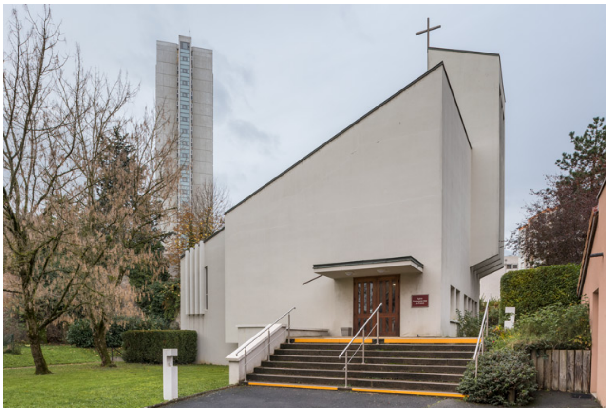
Vue de la façade est.
