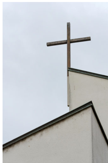
Détail de la croix sur le clocher. Phot. Pierre-Marie Barbe-Richaud IVR26_20227100204NUC4A
