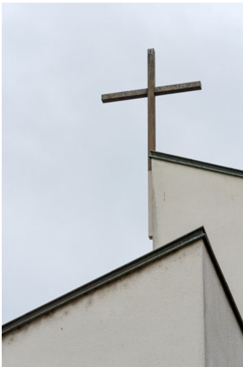
Détail de la croix sur le clocher.
