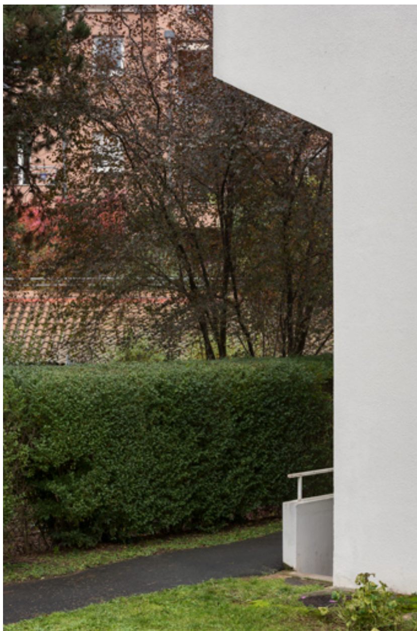
Détail de l'angle nord-ouest du temple.
