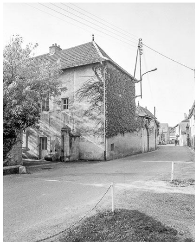
Vue d'ensemble depuis la rue. Phot. Dominique Dominguez IVR43_19807000488X
