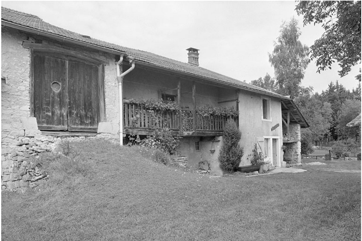
Façade antérieure, balcon en galerie.
