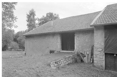
Façade postérieure, grange haute. Phot. Jérôme Mongreville IVR43_19963901095X
