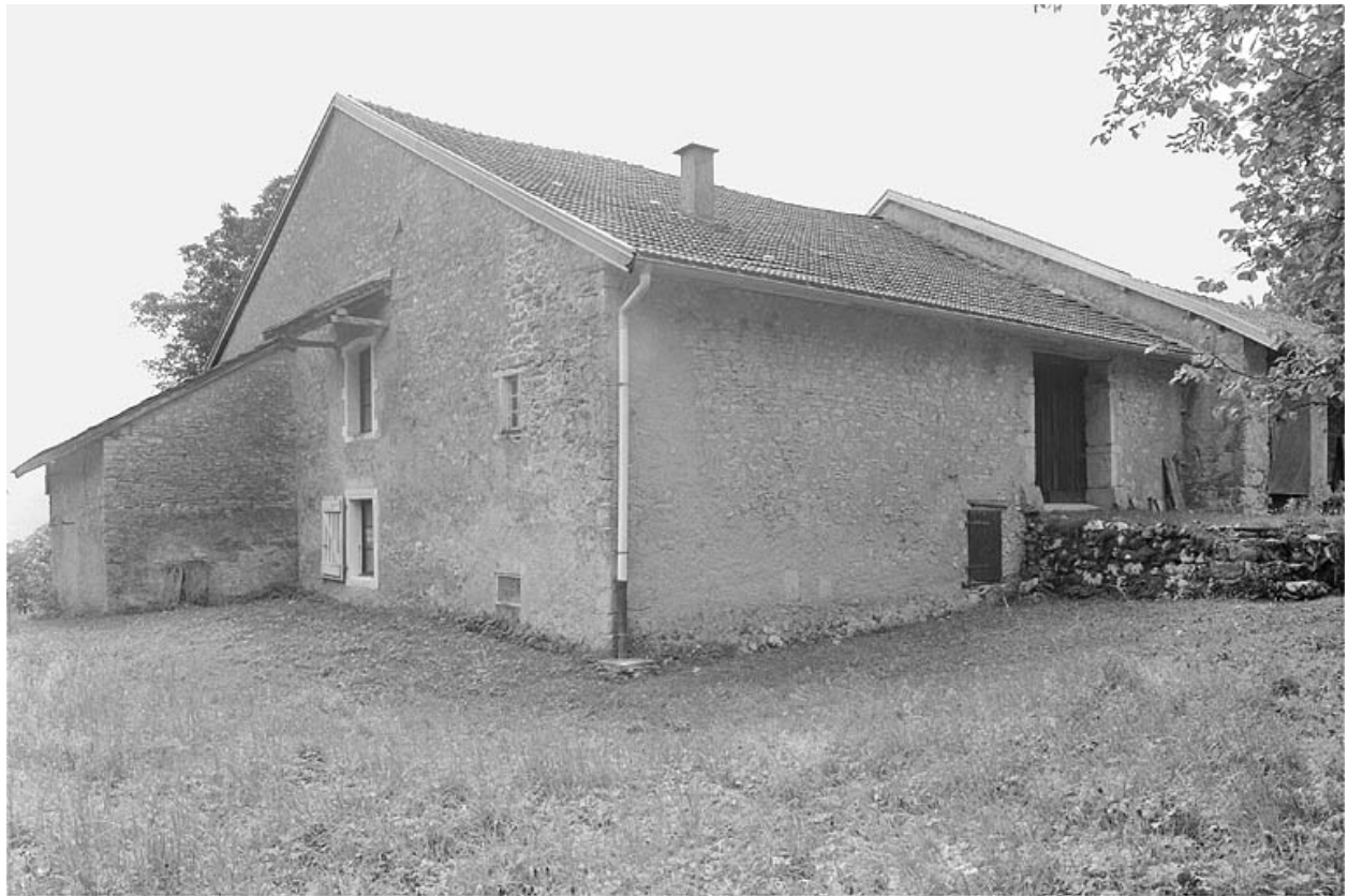
Face droite et façade postérieure.
