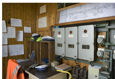
Bureau : vue d'ensemble. Phot. Yves Sancey IVR43_20083900855NUC2A
