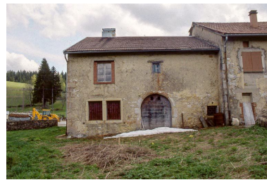
Façade postérieure. Phot. Yves Sancey IVR43_19993900256ZA
