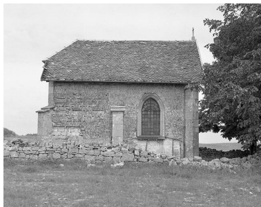
Façade latérale nord. Phot. Yves Sancey IVR43_19752500317X
