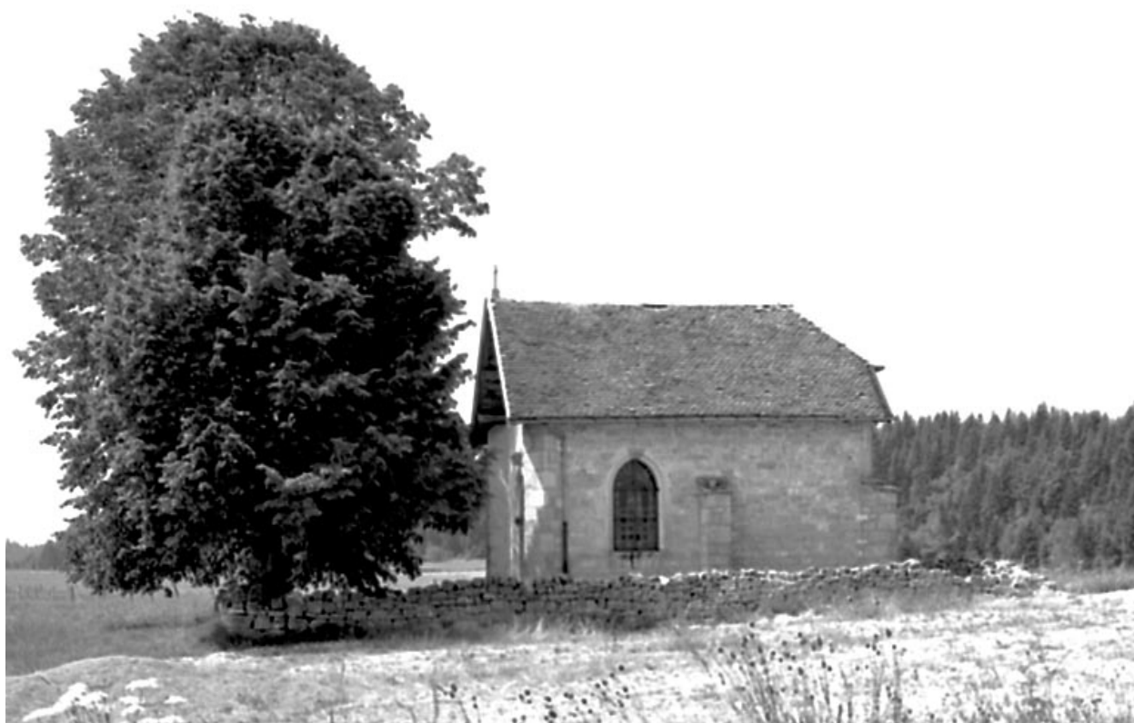
Façade latérale sud.
