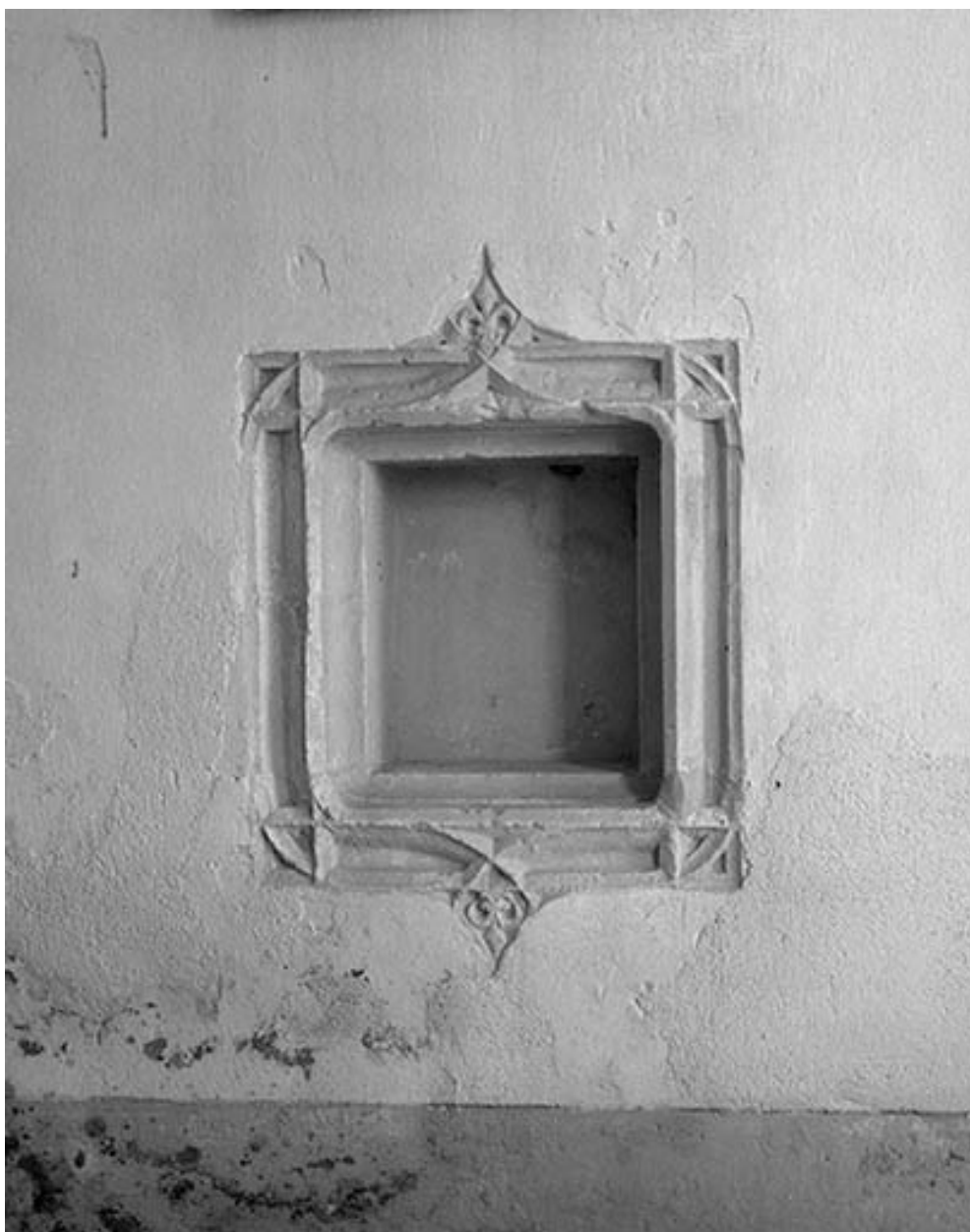
Extérieur : détail, niche.
