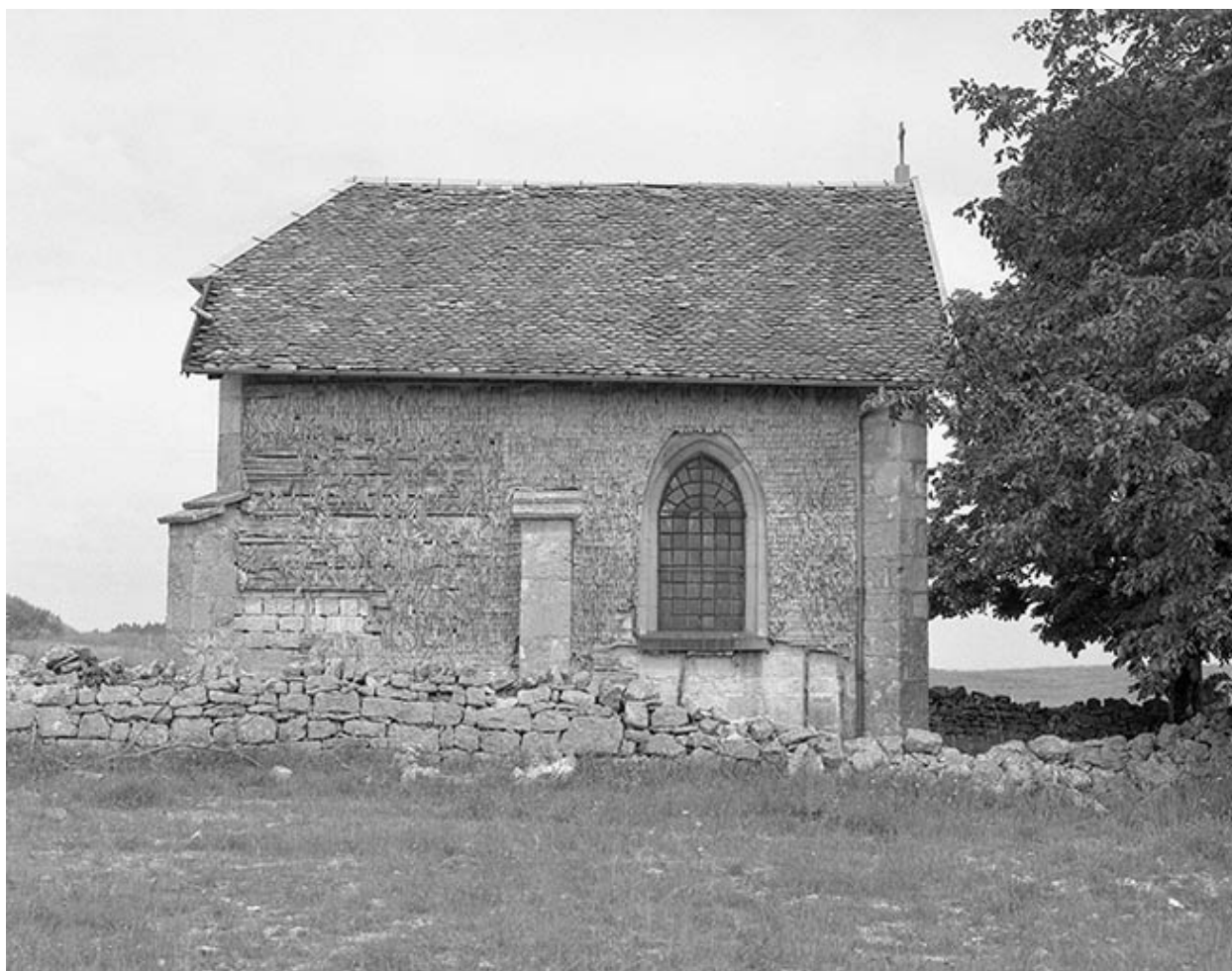
Façade latérale nord.
