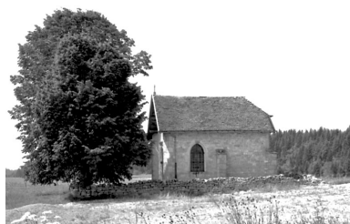
Façade latérale sud. Phot. Yves Sancey IVR43_19752500316X
