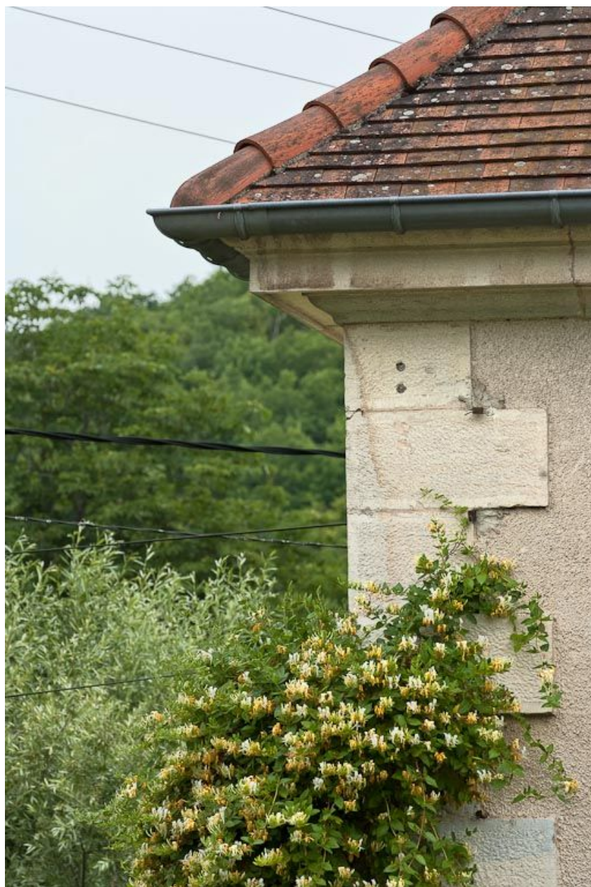
Détails de matériaux de la maison éclusière : corniche et chaîne d'angle.
