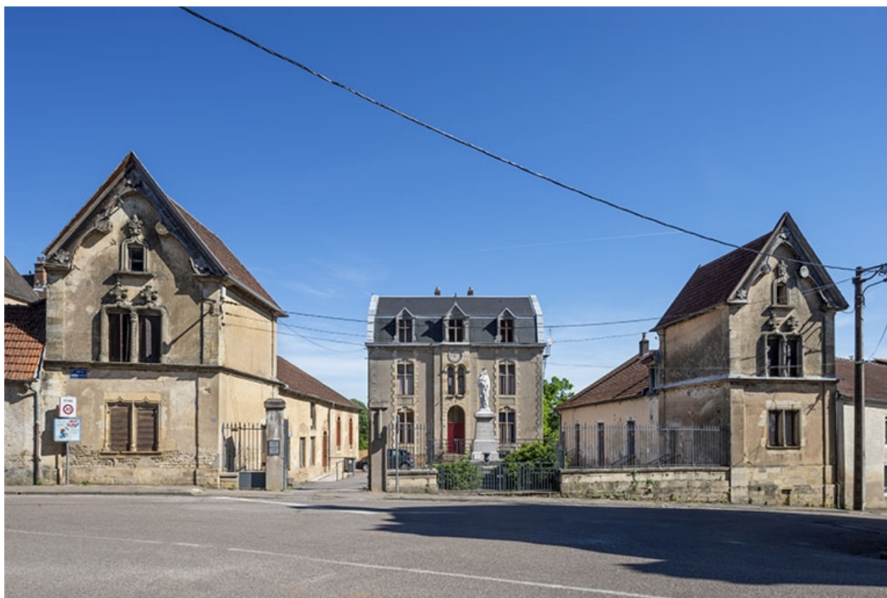
L'ensemble des bâtiments depuis la rue.
