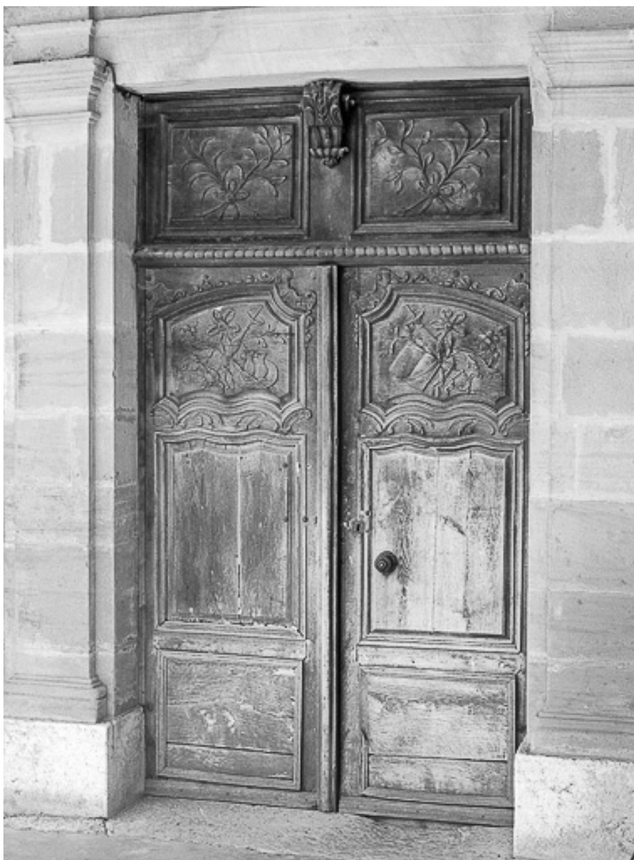
Détail de la deuxième porte d'entrée.
