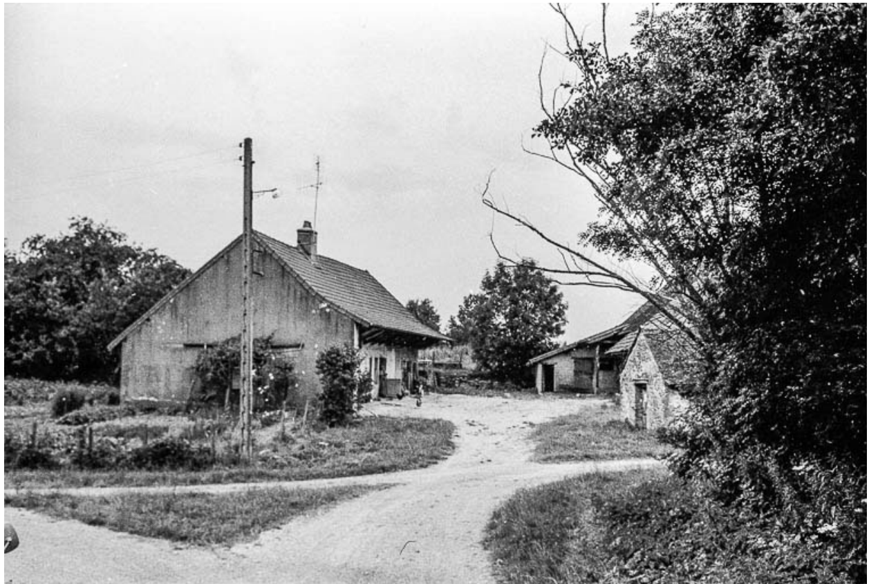
Ferme cadastrée 1969 AC 183 : vue d'ensemble.
