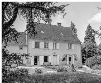
Ferme n° 16 : façade postérieure, partie gauche. Phot. Dominique Dominguez IVR43_19773900094X
