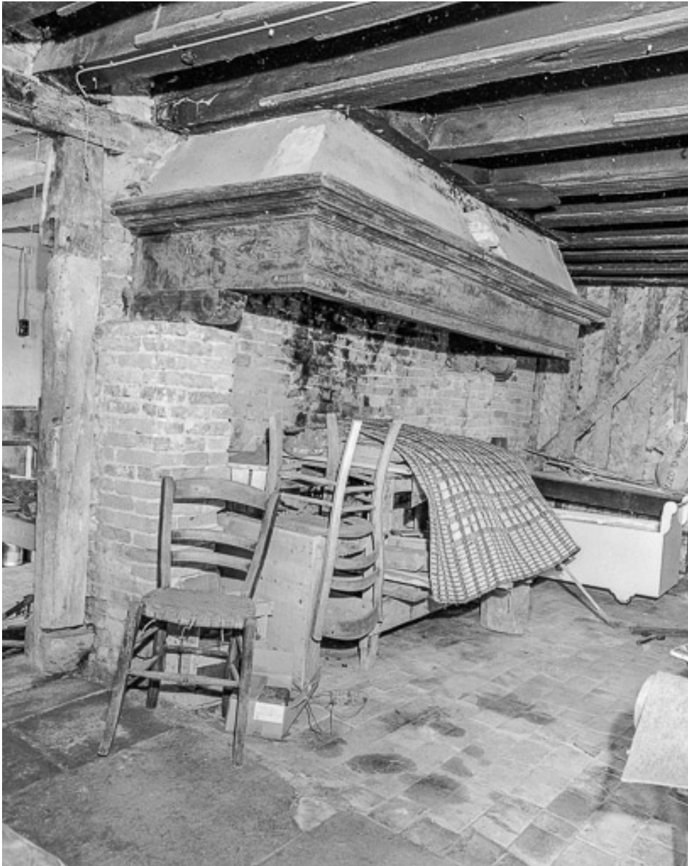
Ferme n° 16 : cheminée de la pièce d'habitation.
