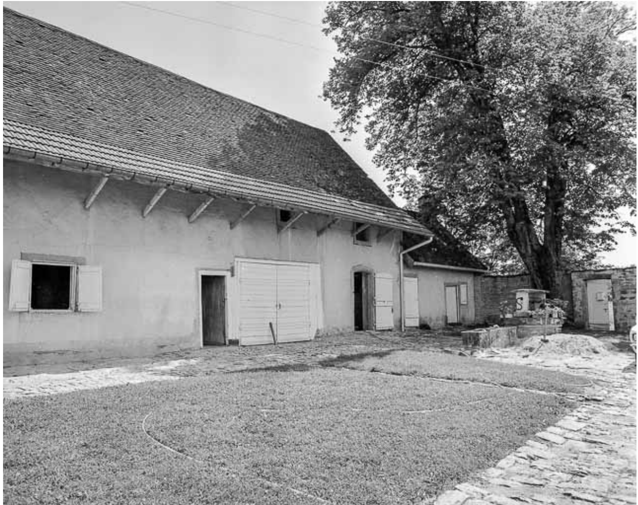
Ferme n° 16 : façade antérieure, partie droite.
