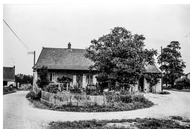
Ferme cadastrée 1969 AD 96 : façade antérieure. Phot. Guy Forestier IVR43_19753900278Z
