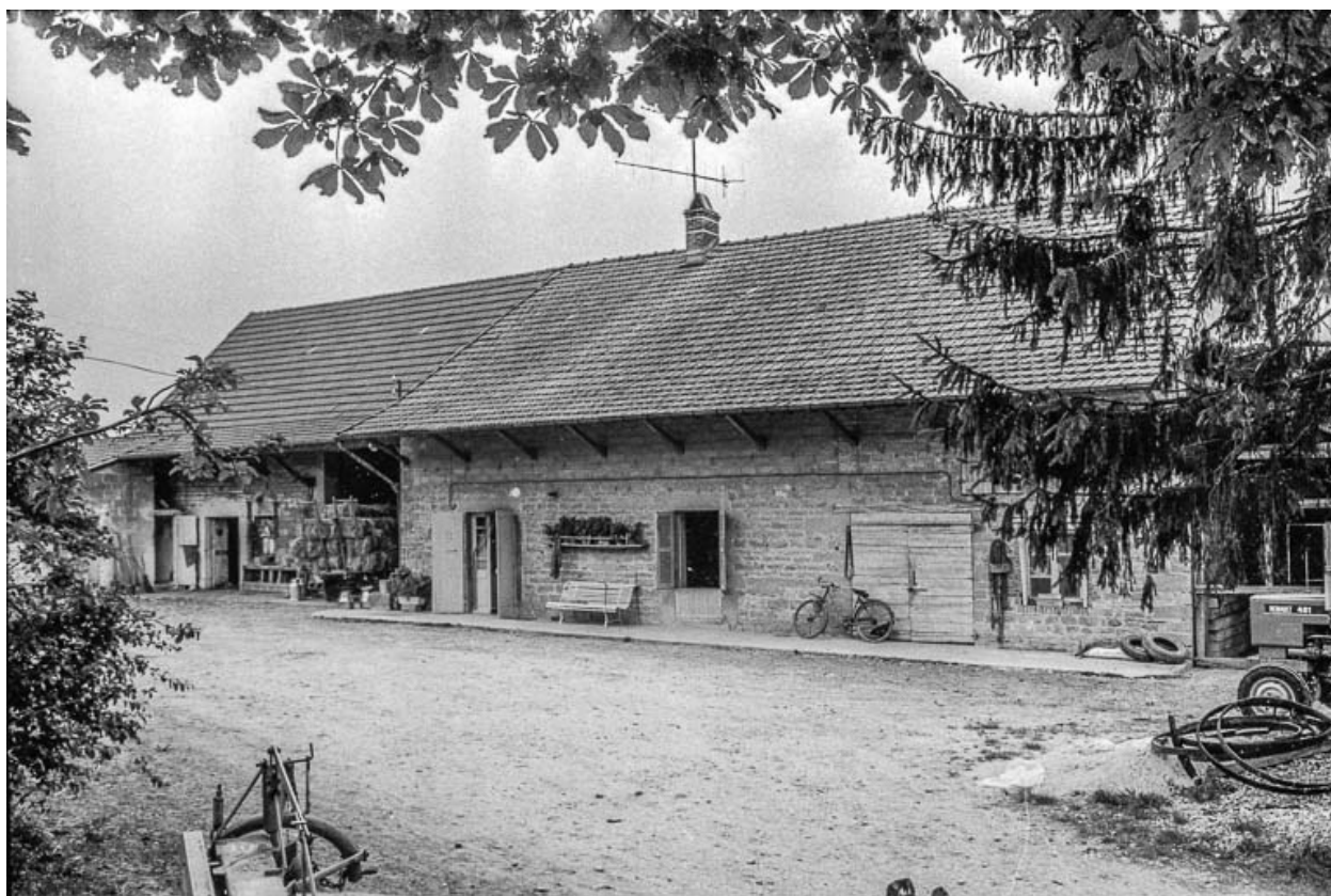
Ferme cadastrée 1969 AD 206-207 : bâtiment agricole.
