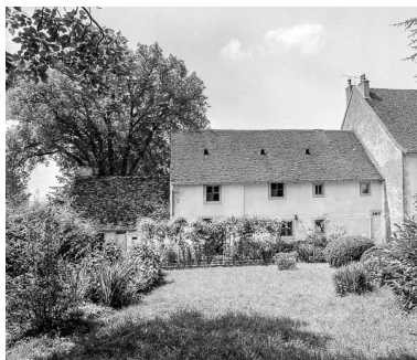
Ferme n° 16 : façade postérieure, partie droite. Phot. Dominique Dominguez IVR43_19773900095X
