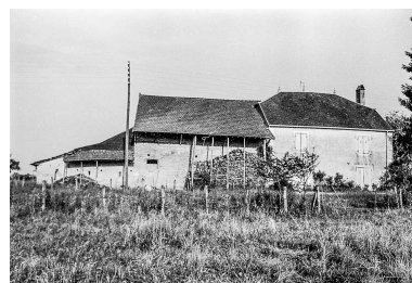
Ferme cadastrée 1969 AD 171-172 : façade postérieure. Phot. Guy Forestier IVR43_19753900281Z
