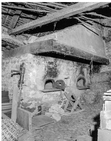
Ferme n° 16 : ensemble de deux fours. Phot. Dominique Dominguez IVR43_19773900100X
