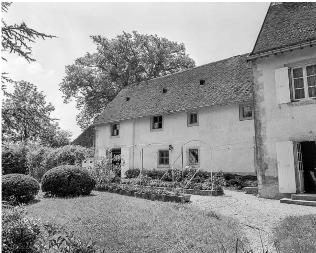
Ferme n° 16 : façade postérieure.
