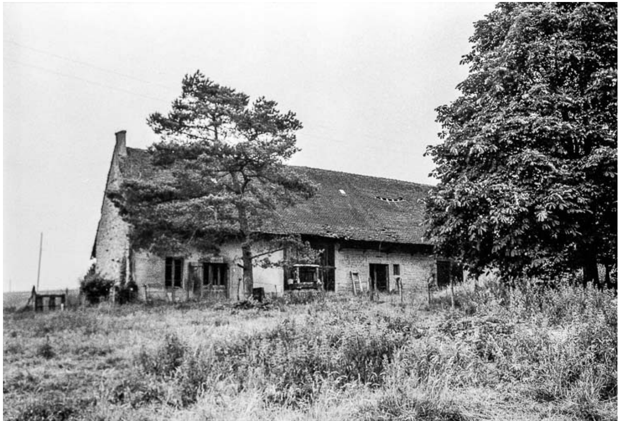
Ferme cadastrée 1969 AL 20 : façade antérieure.
