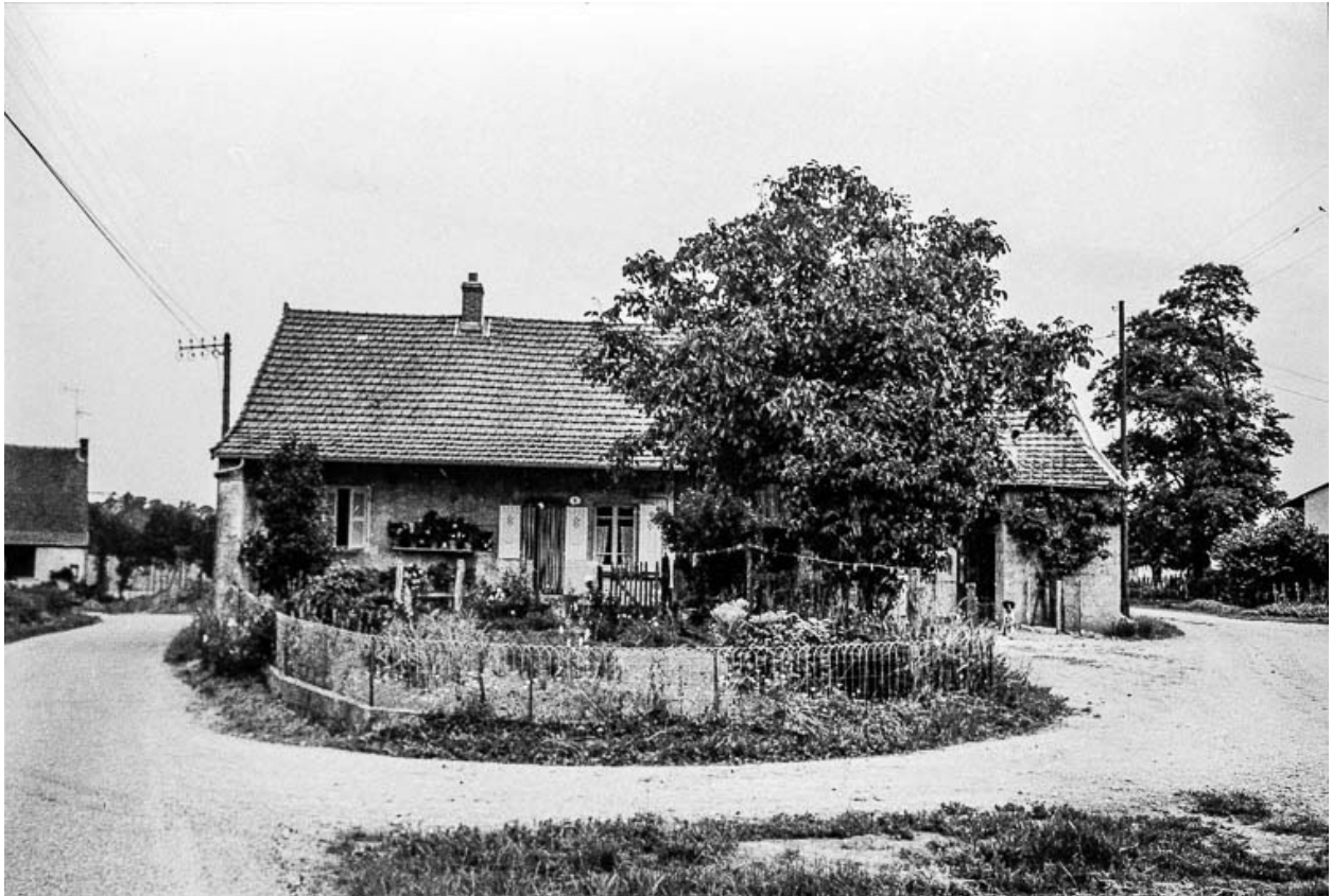
Ferme cadastrée 1969 AD 96 : façade antérieure.
