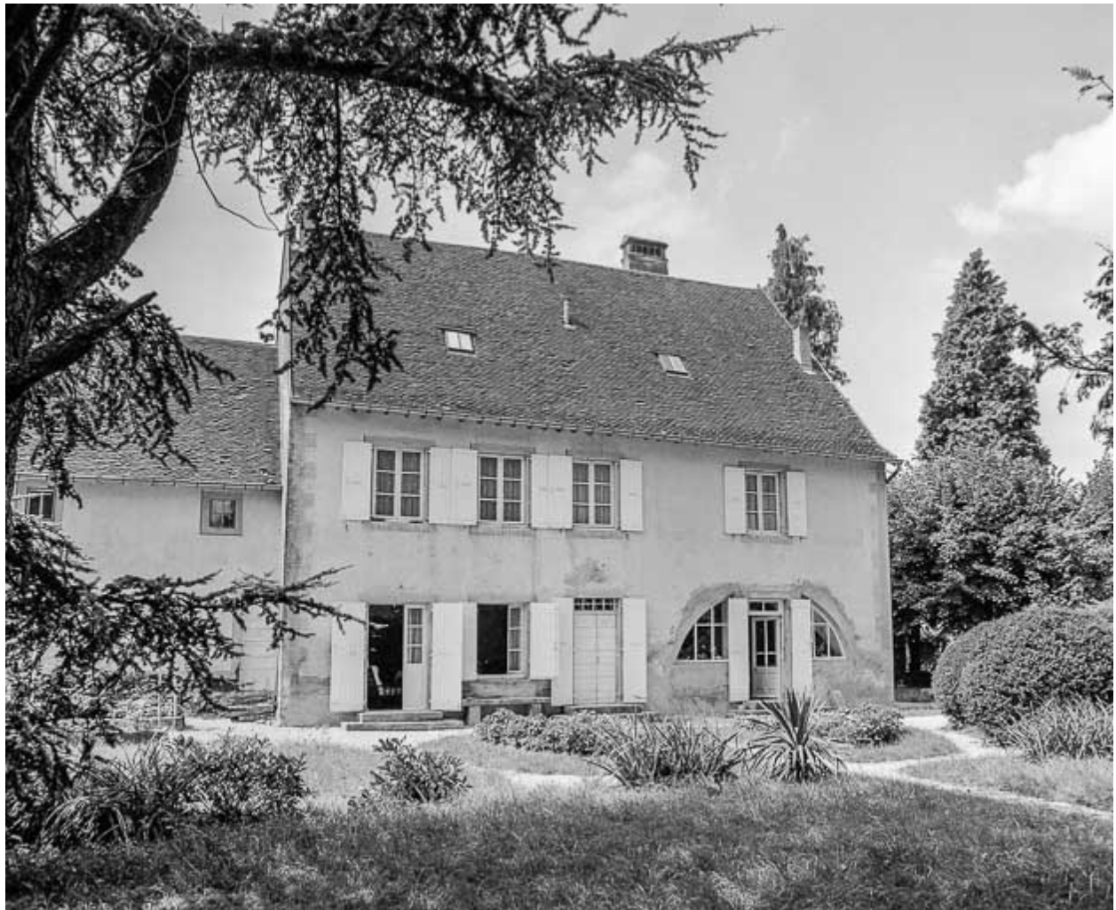
Ferme n° 16 : façade postérieure, partie gauche.
