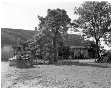
Ferme située au lieudit La Rue du Bois. Phot. Dominique Dominguez IVR43_19773900106X
