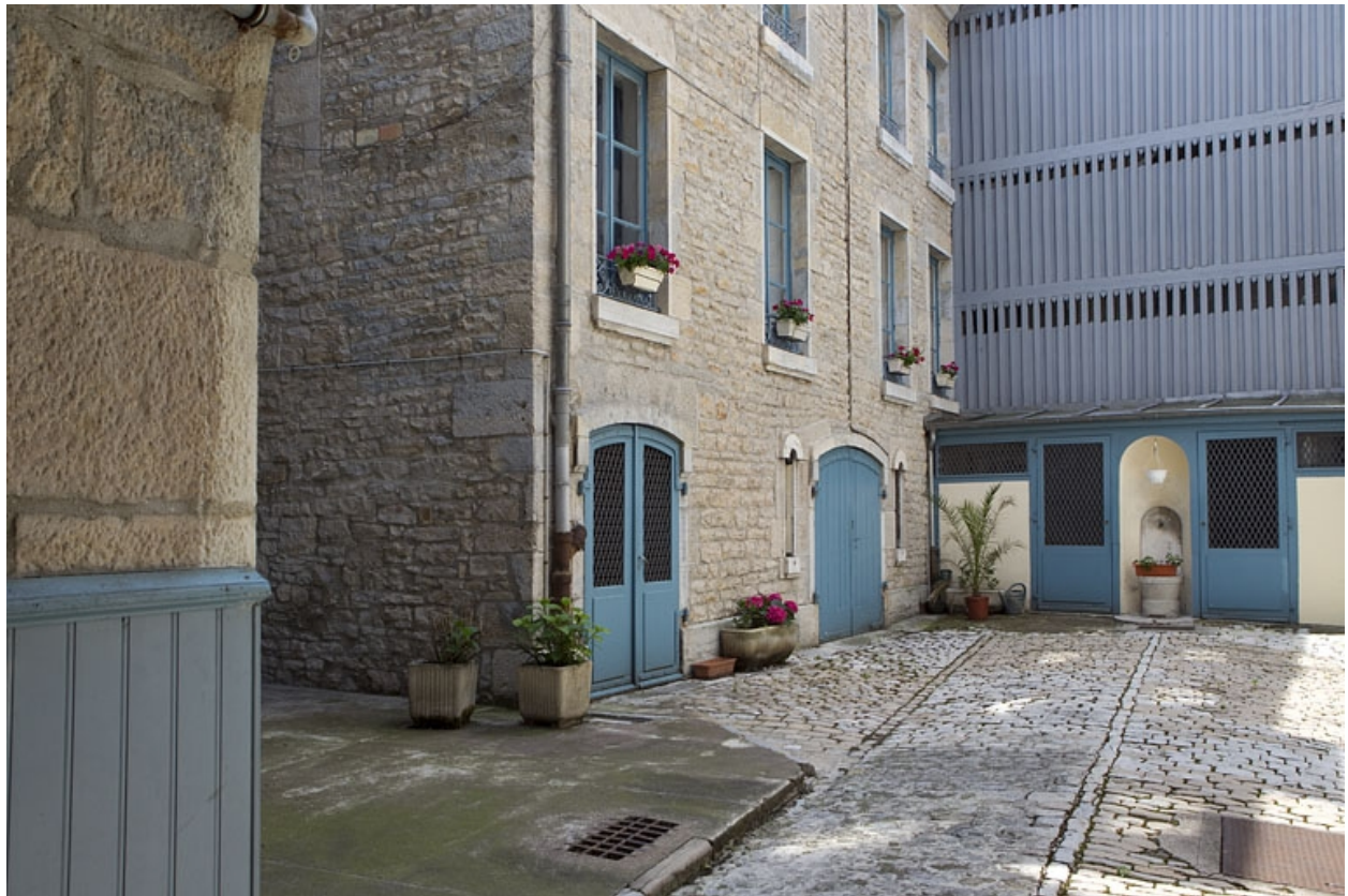
Détail du rez-de-chaussée du logis secondaire gauche.
