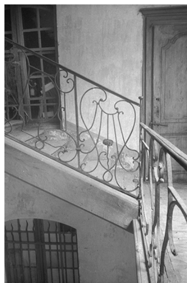
Cage d'escalier. Ferronnerie du garde-corps, s.d. [vers 1960]. Phot. Georges Chenu IVR43_20243901206NUC4A
