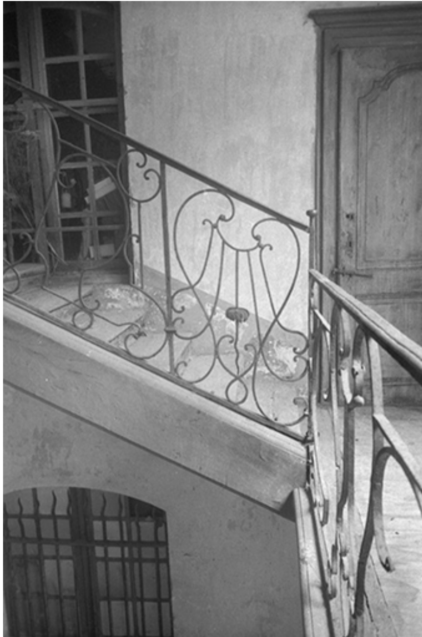
Cage d'escalier. Ferronnerie du garde-corps, s.d. [vers 1960].
