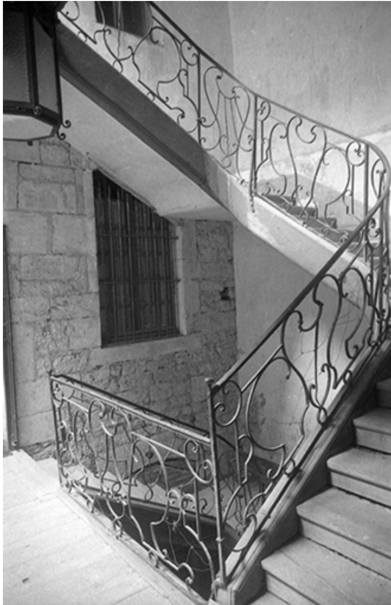
Cage d'escalier. Le second étage, s.d. [vers 1960].
