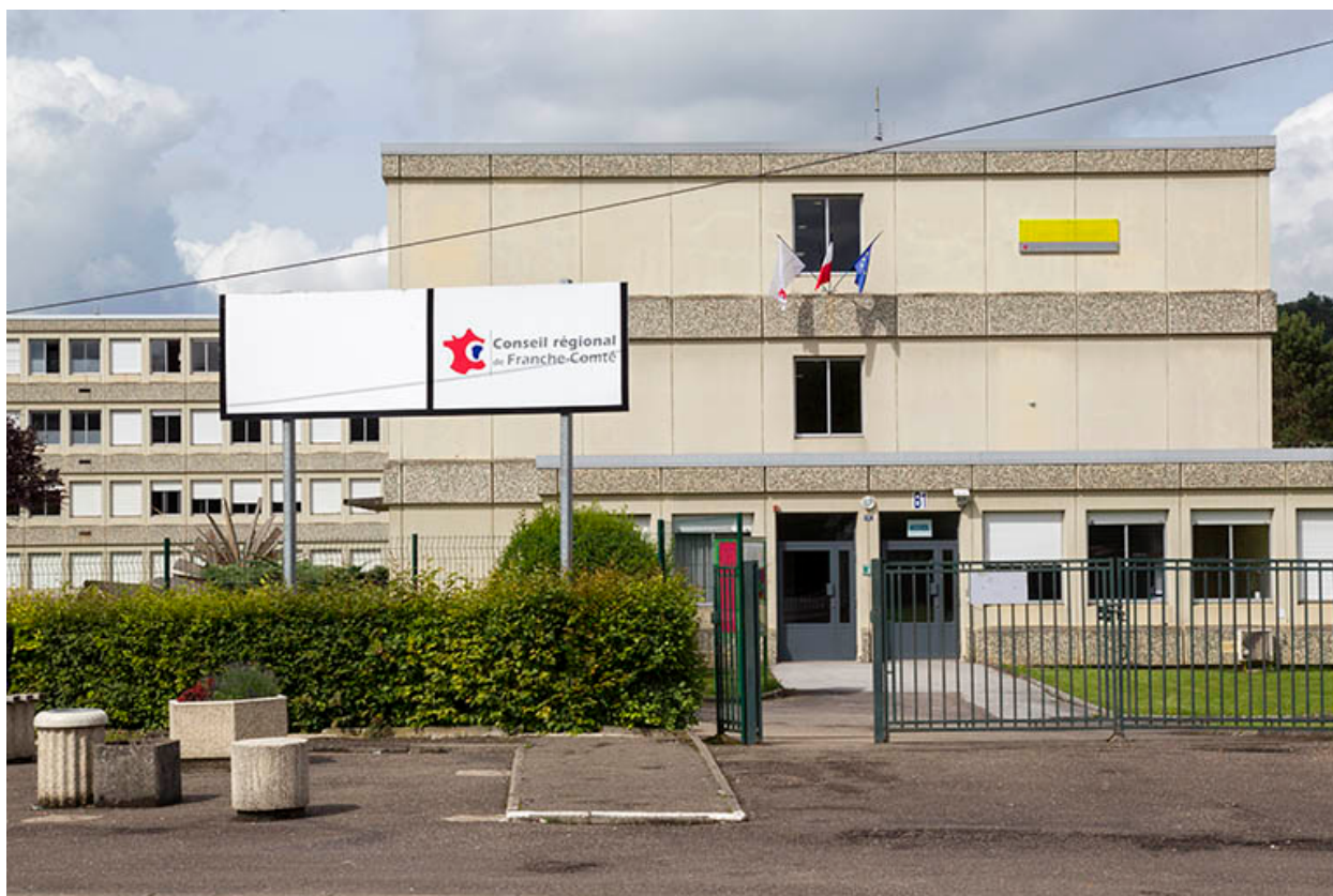
Entrée principale, façade est de l'administration.
