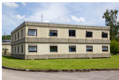
Façade sud-ouest et pignon nord-ouest des logements. Phot. Sonia Dourlot IVR43_20142501058NUC2A
