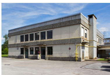
Façade nord du bâtiment de restauration. Phot. Sonia Dourlot IVR43_20142501077NUC2A
