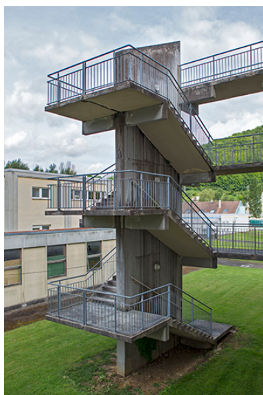
Escalier de l'internat. Phot. Sonia Dourlot IVR43_20142501042NUC2A
