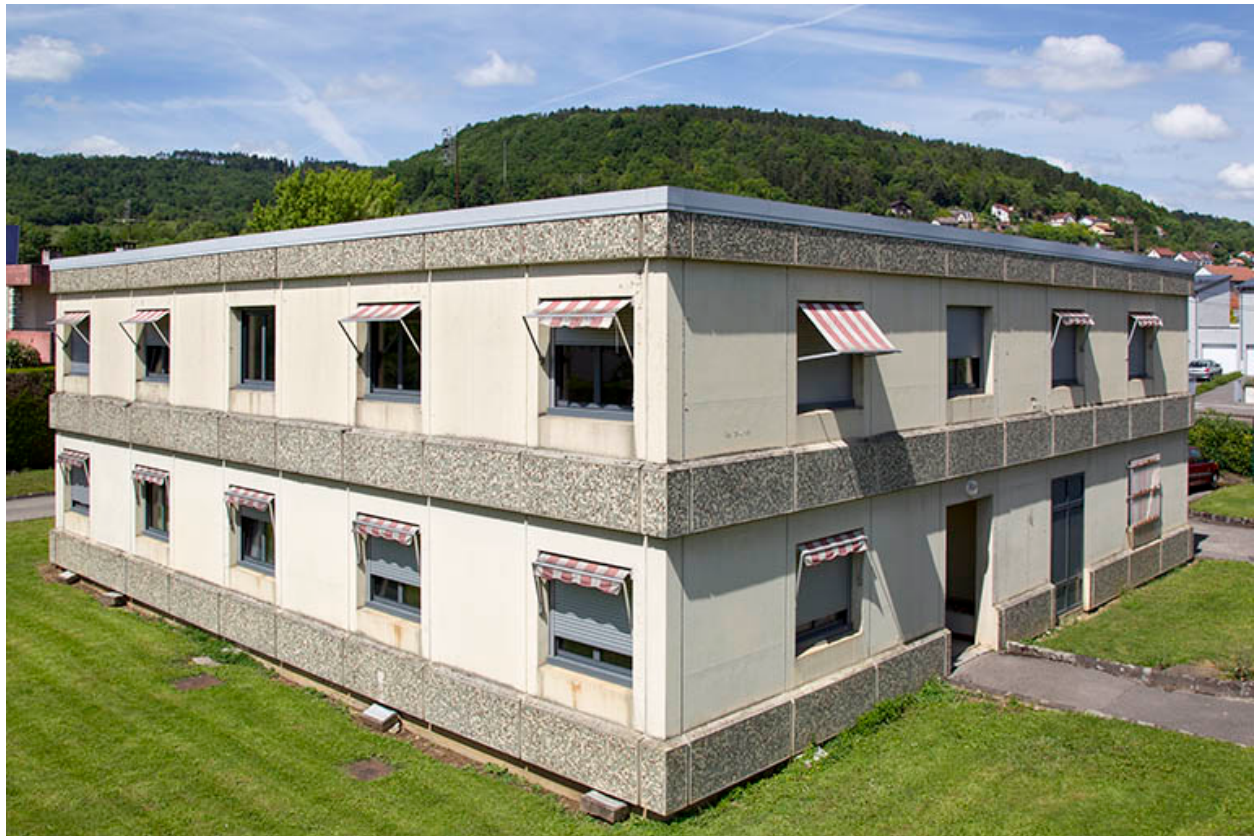
Angle sud des logements.
