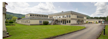
Vues d'ensemble du nord- est à côté des logements : la restauration, l'administration, l'atelier de maintenance. Phot. Sonia Dourlot IVR43_20142501070NUC4AQ
