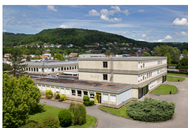
Angle sud de l'externat, vu de l'internat. Phot. Sonia Dourlot IVR43_20142501035NUC2A
