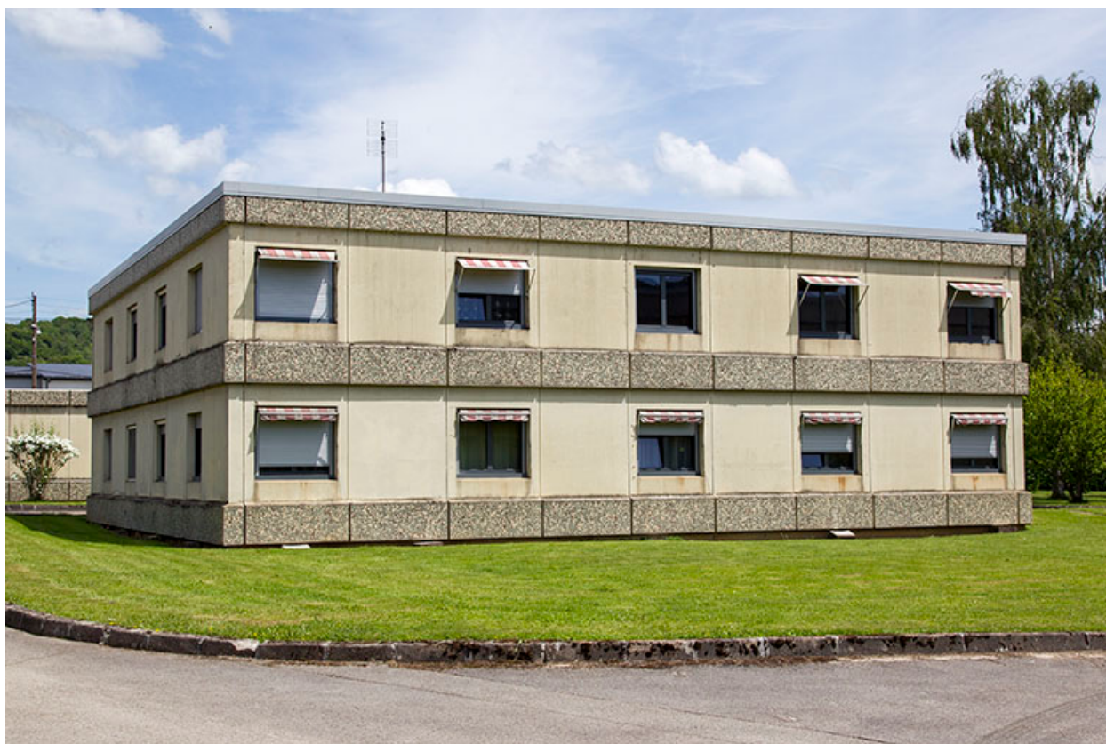
Façade sud-ouest et pignon nord-ouest des logements.
