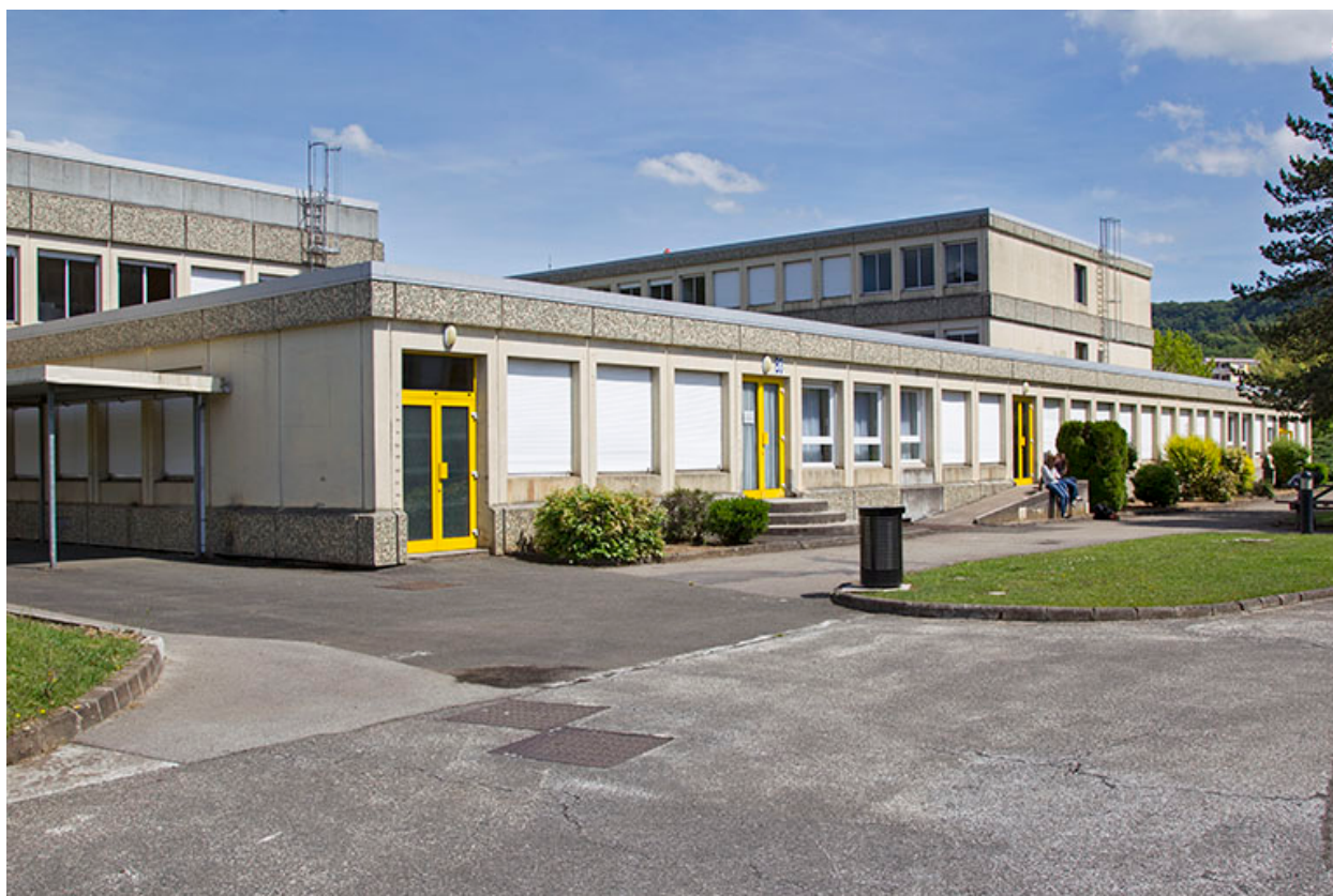
Façade ouest du bâtiment d'enseignement bio services.
