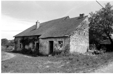
Bâtiment annexe dans la cour. Phot. Bernard Lardière IVR43_19817000606Z
