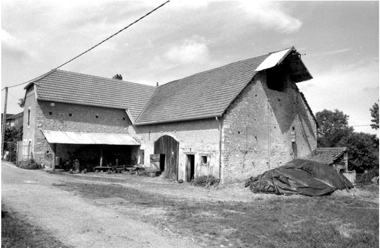
Vue d'ensemble depuis la rue Cazelle.
