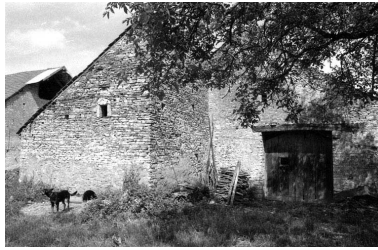
Remise et four : façade sur rue. Phot. Bernard Lardière IVR43_19817000605Z
