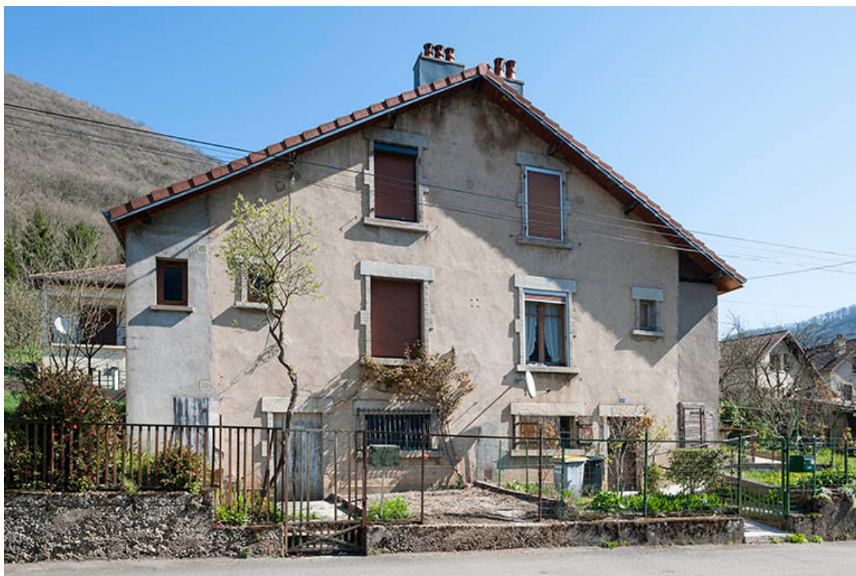
Façade antérieure d'une maison jumelée.
