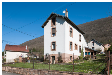
Maison individuelle, à un étage carré. Phot. Jérôme Mongreville IVR43_20152501062NUC4A
