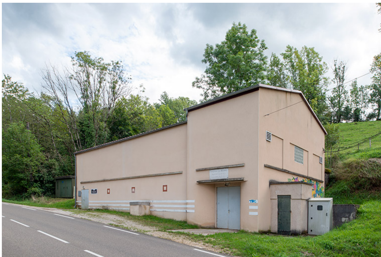
Station de stérilisation (1937), R.D. 472.
