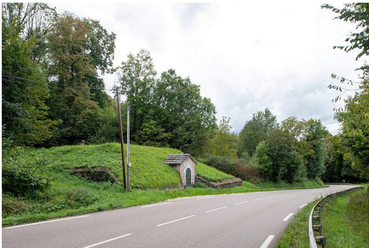
Réservoir de Veley (1910), R.D. 472. Vue depuis l'est.
