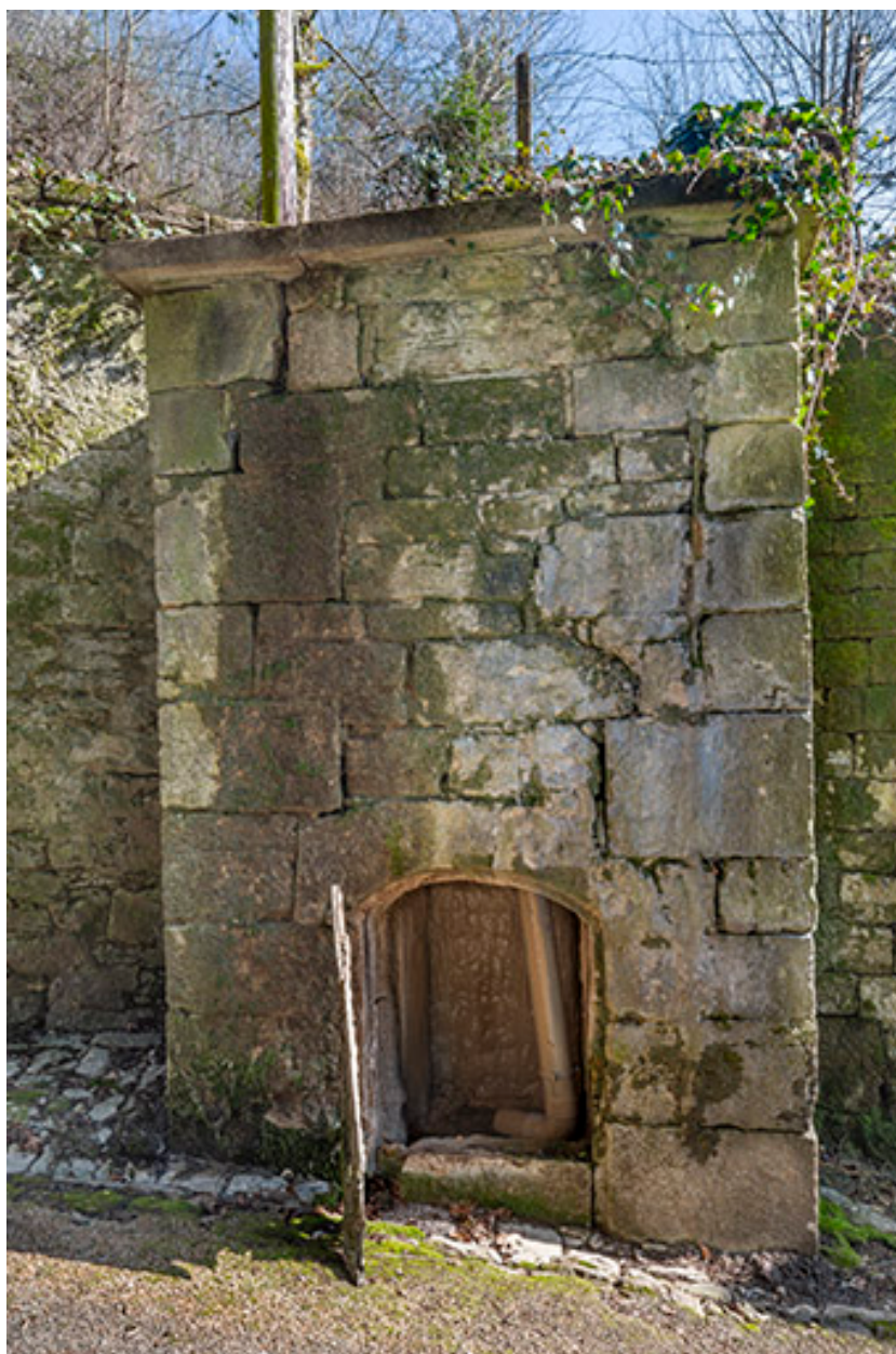
Escalier de Saint-Anatoile. Vue rapprochée du captage.
