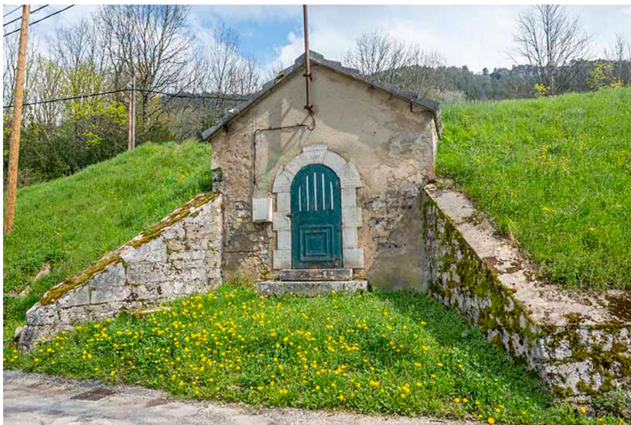
Réservoir de Chambenoz (1910). Côté ouest.
