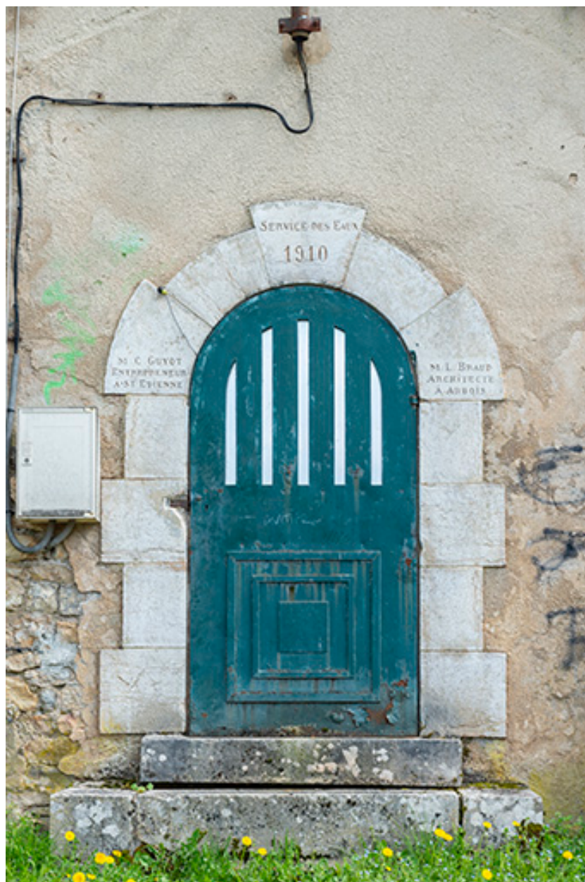
Réservoir de Chambeoz, 1910. Porte du réservoir.
