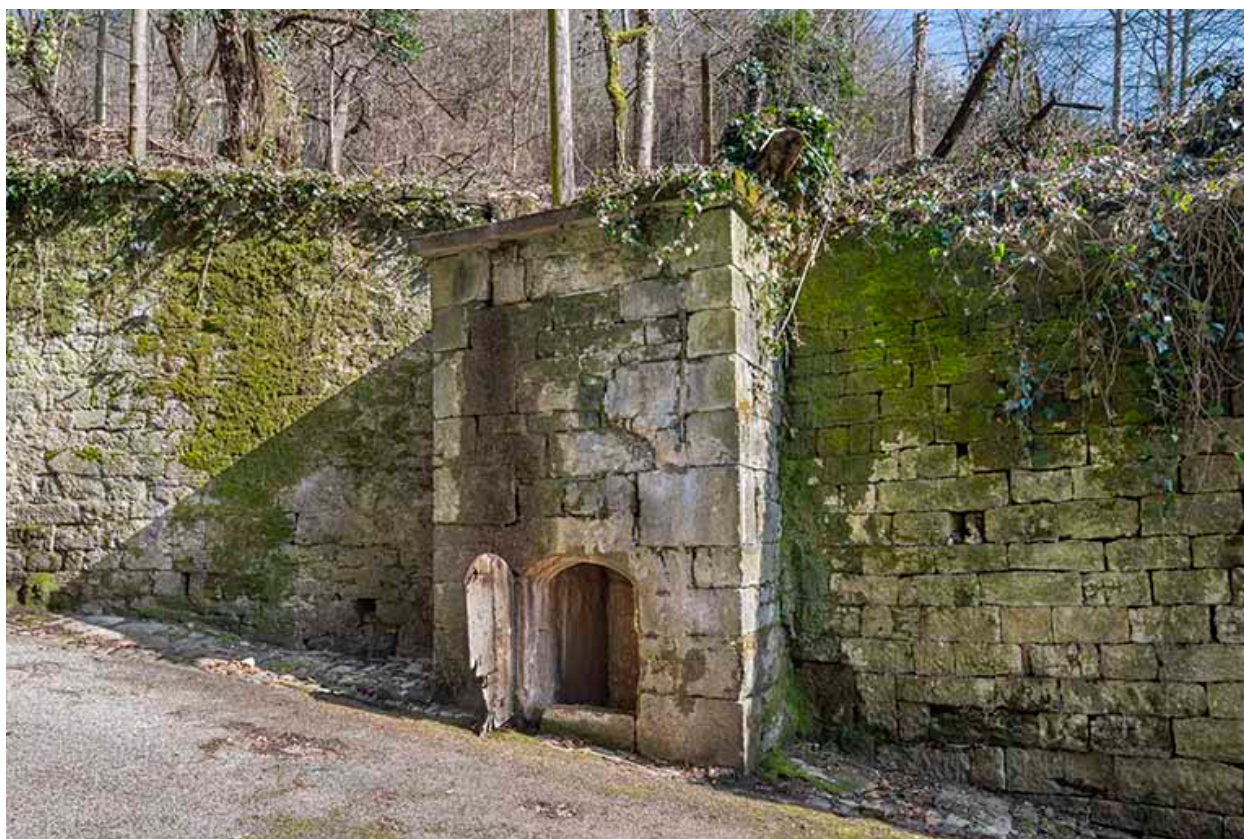
Escalier de Saint-Anatoile. Captage d'une source.
