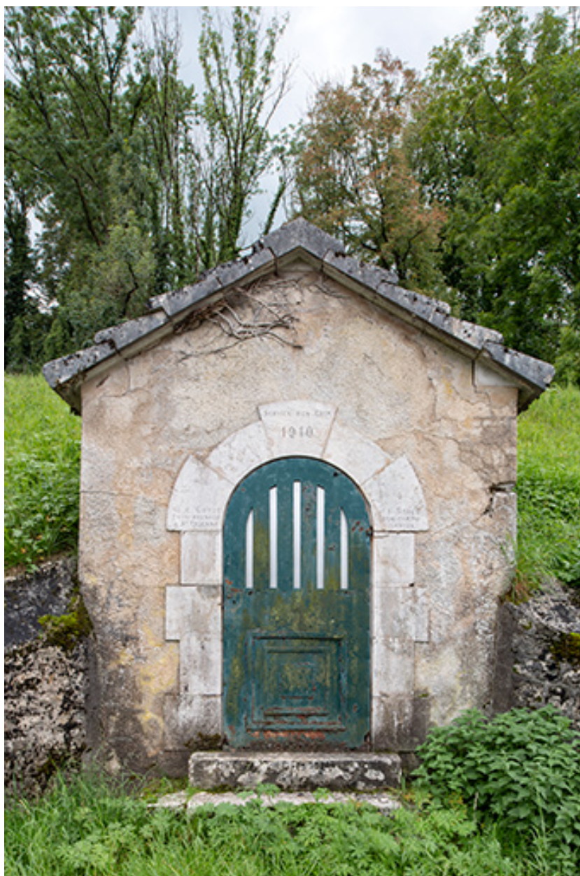
Réservoir de Veley (1910). Façade nord.
