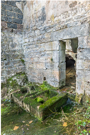
Source d'Arelle (entrée nord de la ville, R.D. 472) Phot. Jérôme Mongreville IVR43_20243900589NUC4A
