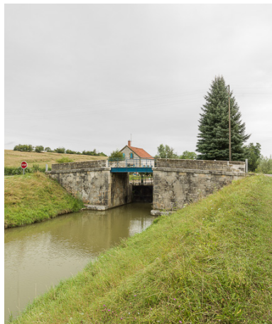
Vue d'ensemble du pont.
