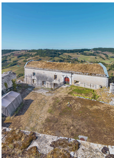
Vue depuis le toit du cavalier. Phot. Thierry Kuntz IVR43_20223900666NUC4A
