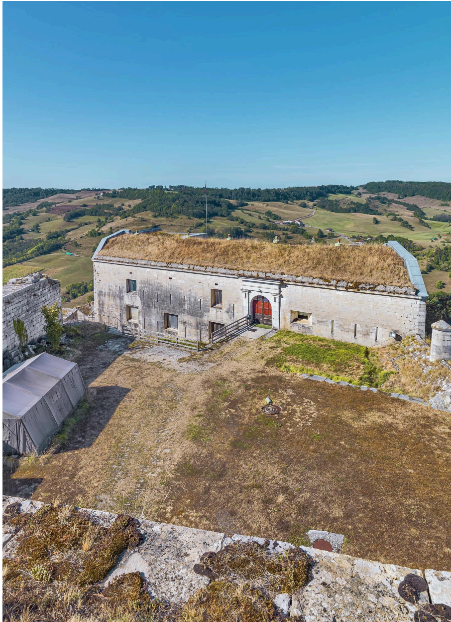
Vue depuis le toit du cavalier.
