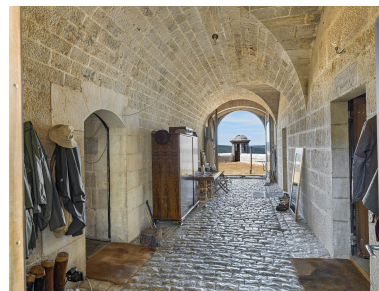
Le vestibule du réduit. Phot. Thierry Kuntz IVR43_20223900661NUC4A
