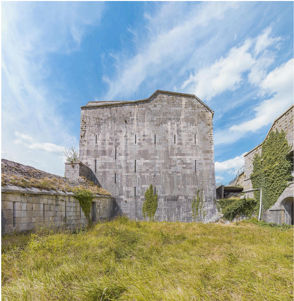
Mur pignon sud du réduit.
