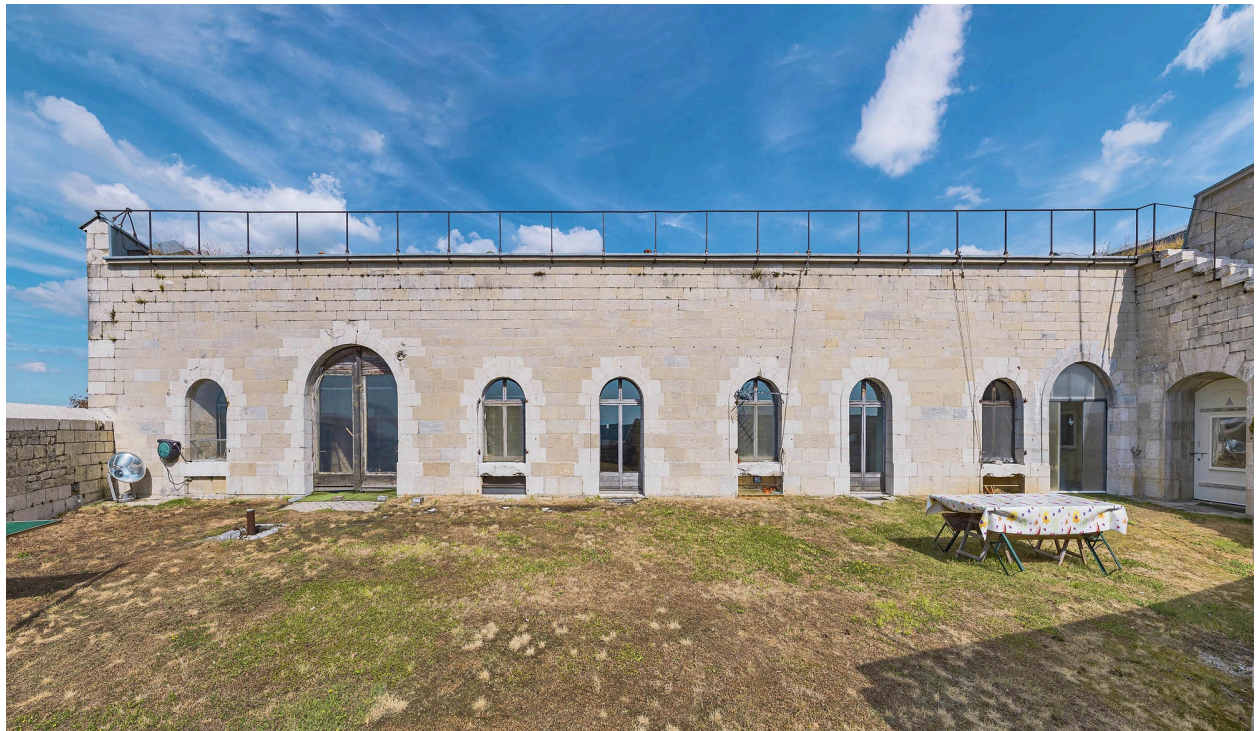
Vue générale de la façade postérieure.
