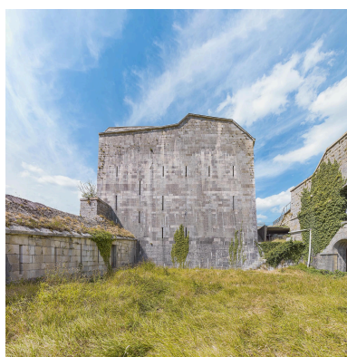
Mur pignon sud du réduit. Phot. Thierry Kuntz IVR43_20223901097NUC4A
