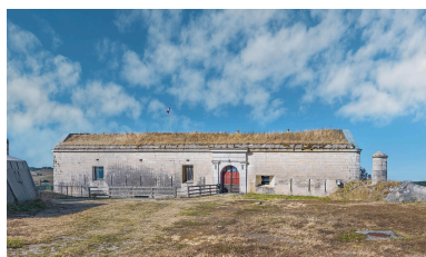
Vue générale. Phot. Thierry Kuntz IVR43_20223901187NUC4A
