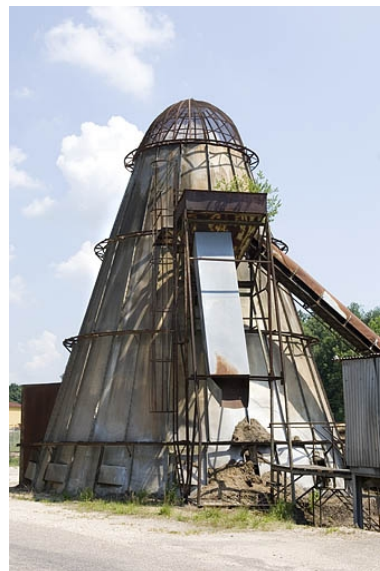
Four à écorces américain, depuis l'ouest. Phot. Jérôme Mongreville IVR43_20097000716NUC2A
