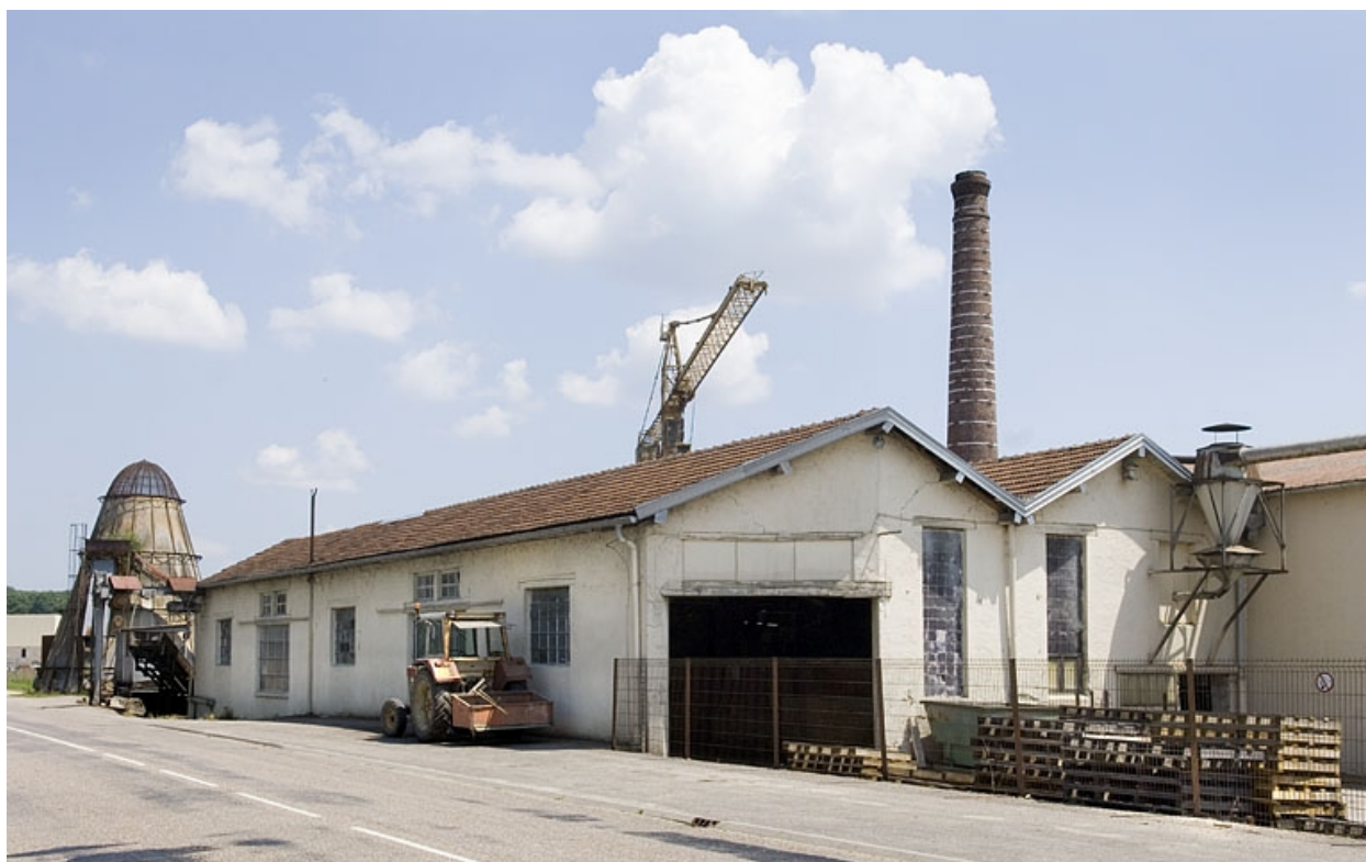
Atelier de fabrication (scie à ruban).
