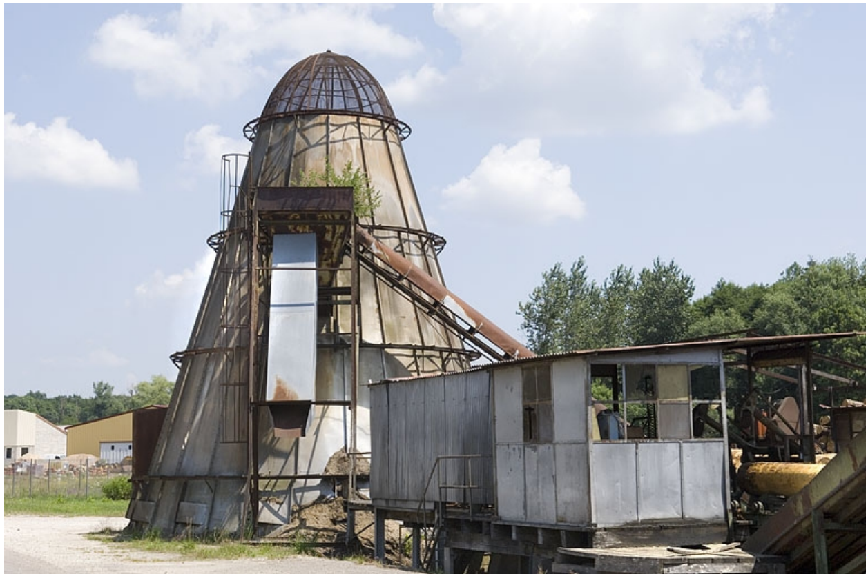
Poste d'écorçage et four à écorces.
