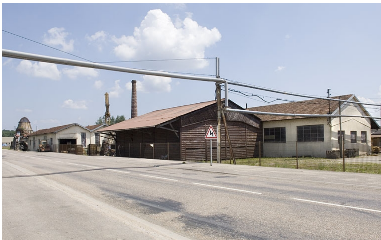
Vue d'ensemble depuis la rue Emile Hauviller.
