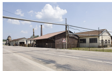
Vue d'ensemble depuis la rue Emile Hauviller. Phot. Jérôme Mongreville IVR43_20097000719NUC2A
