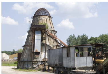
Poste d'écorçage et four à écorces. Phot. Jérôme Mongreville IVR43_20097000717NUC2A
