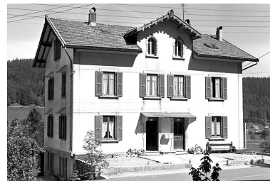
Façade antérieure vue de trois quarts. Phot. Jérôme Mongreville IVR43_20013900456X
