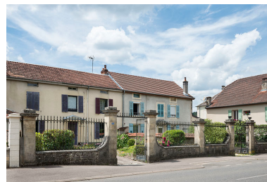
Maisons n° 28-32. Phot. Jérôme Mongreville IVR43_20187000391NUC4A
