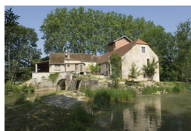
Vue d'ensemble depuis le barrage. Phot. Jérôme Mongreville IVR43_20087000578NUC2A
