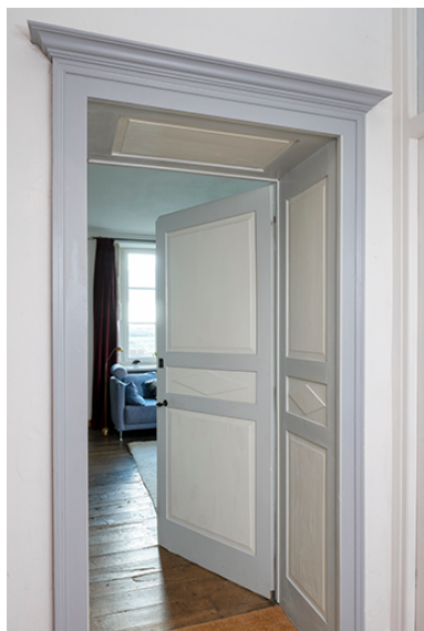
Rez-de-chaussée : détail de baie et menuiserie.
