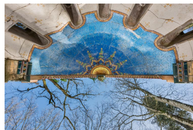
Voûte de l'abside. Phot. Pierre-Marie Barbe-Richaud IVR26_20245800169NUC4A
