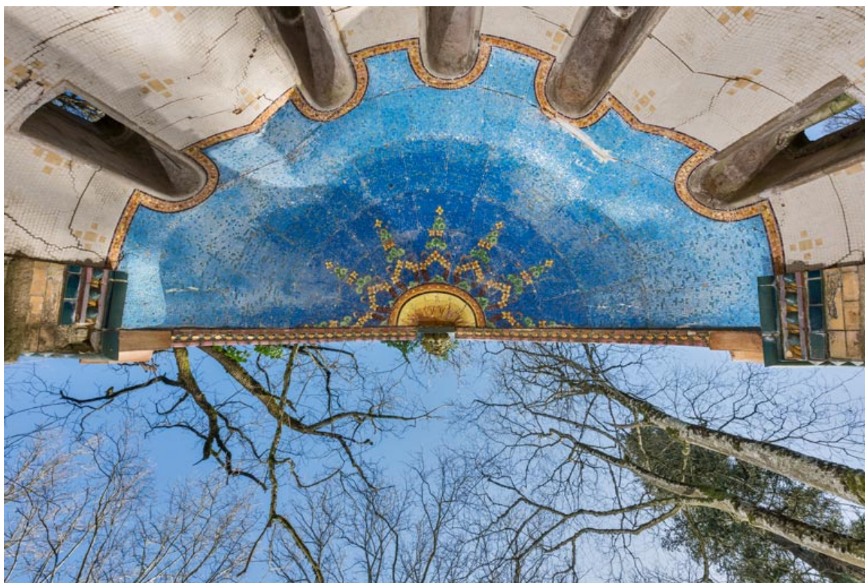
Voûte de l'abside.
