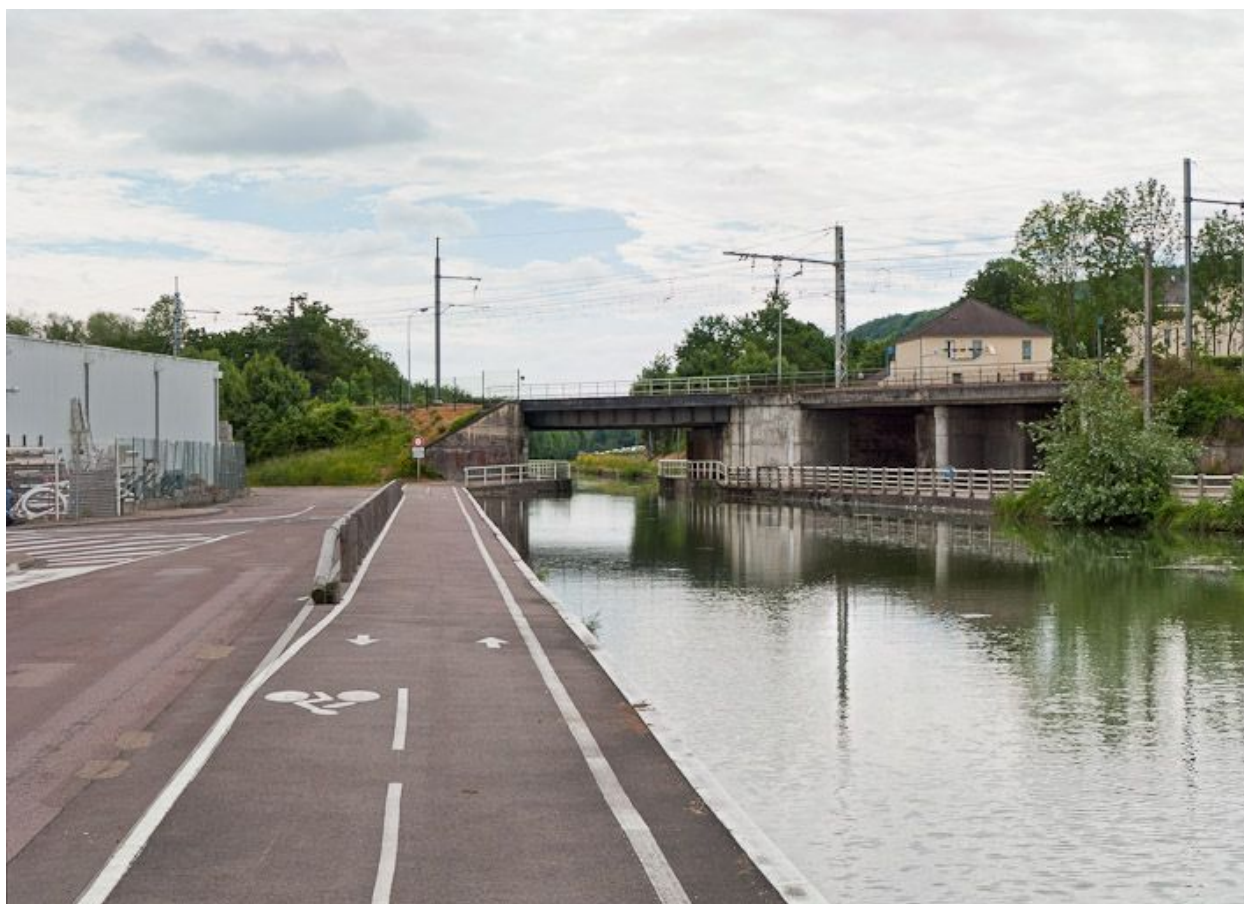
Vue d'ensemble du pont.
