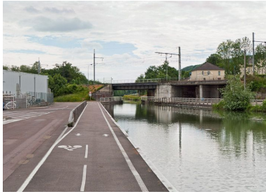
Vue d'ensemble du pont.
