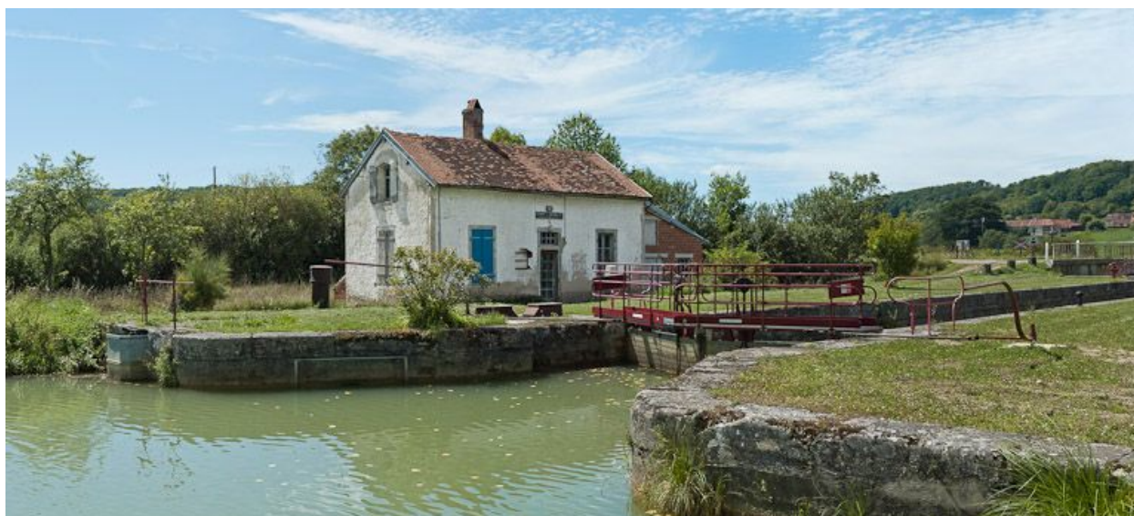
Vue d'ensemble du site d'écluse.
