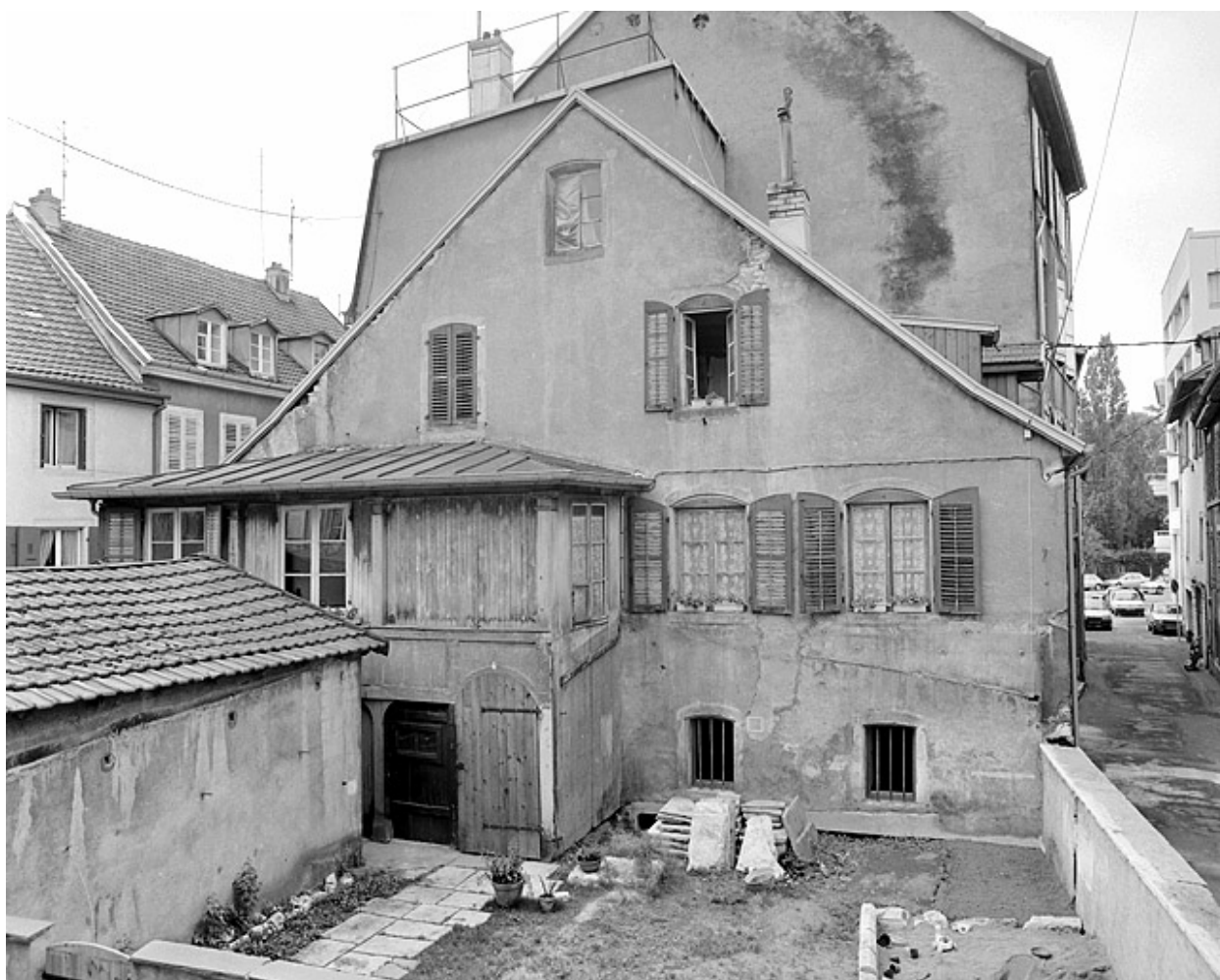
Façade sur cour.
