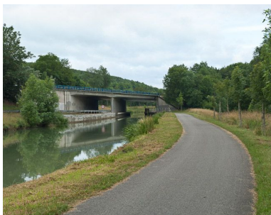
Vue d'ensemble du pont.
