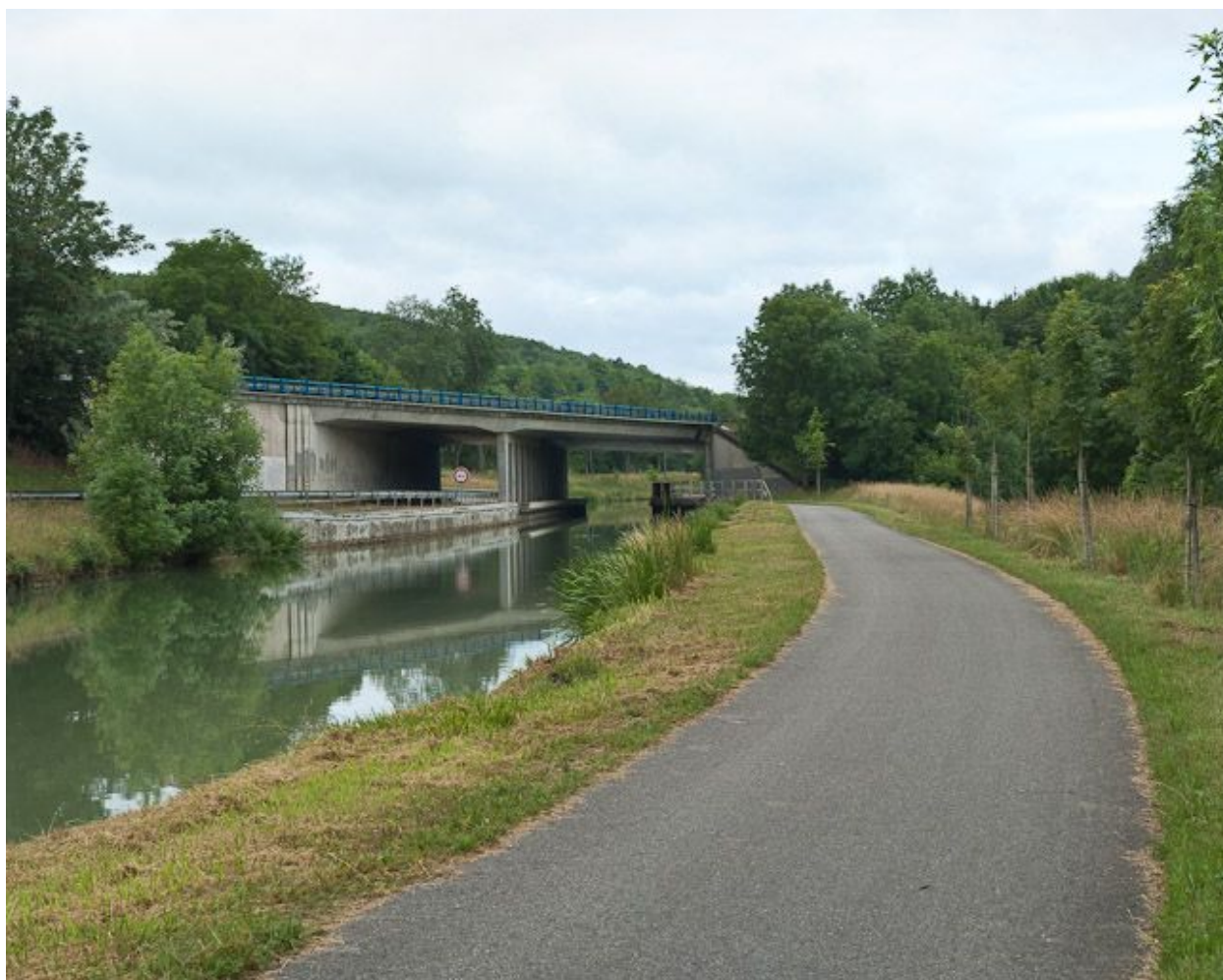
Vue d'ensemble du pont.
