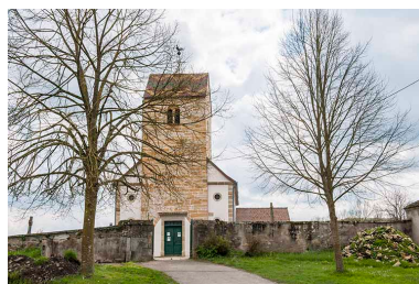
Vue depuis la route de l'Eglise. Phot. Jérôme Mongreville IVR43_20167000333NUC4A
