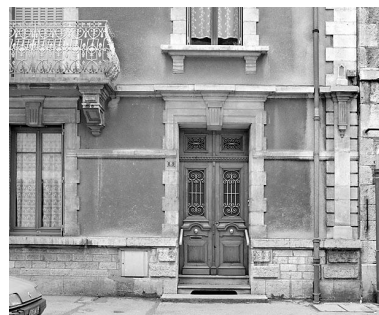
Elévation antérieure : porte. Phot. Yves Sancey IVR43_20033900113X
