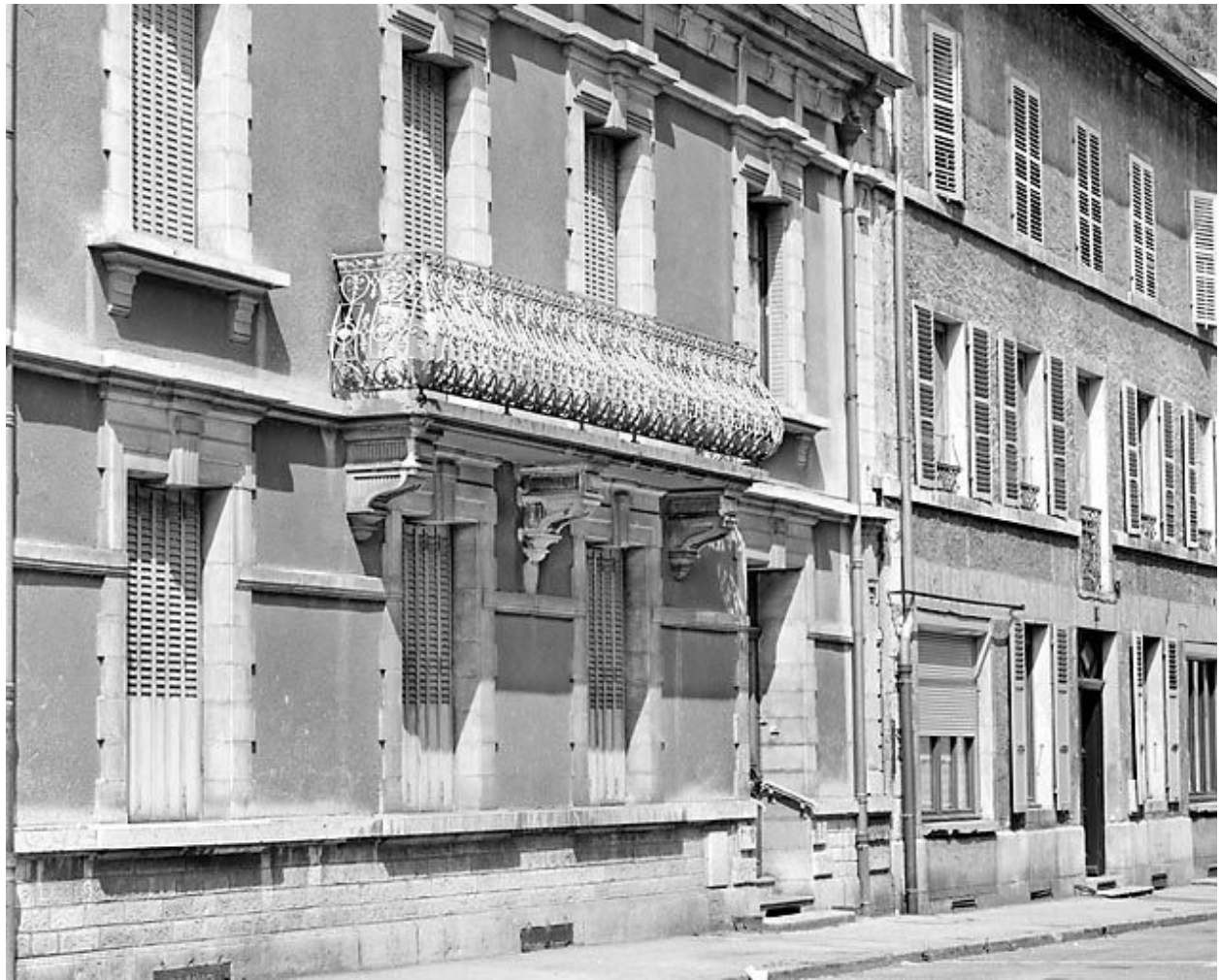
Elévation antérieure : baies.
