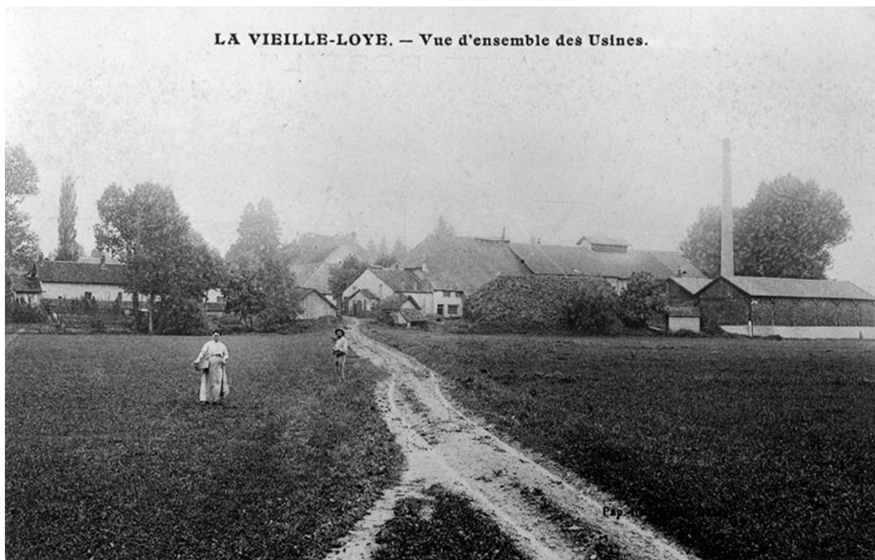
La Vieille-Loye. - Vue d'ensemble des Usines.
