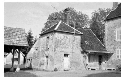
Pavillon nord du logement patronal. Phot. Laurent Poupard IVR43_19883900467Z
