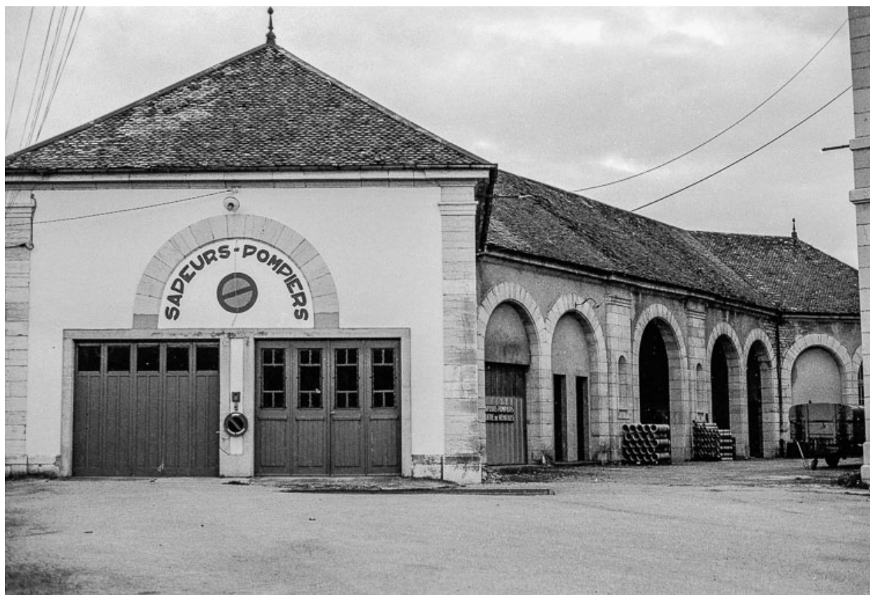
Vue des parties constitutantes en 1975 : remise sapeurs-pompiers.
