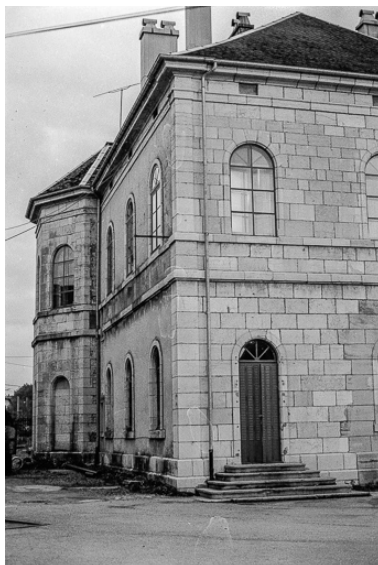
Façade postérieure en 1975. Phot. Liliane Hamelin IVR43_19752501217Z
