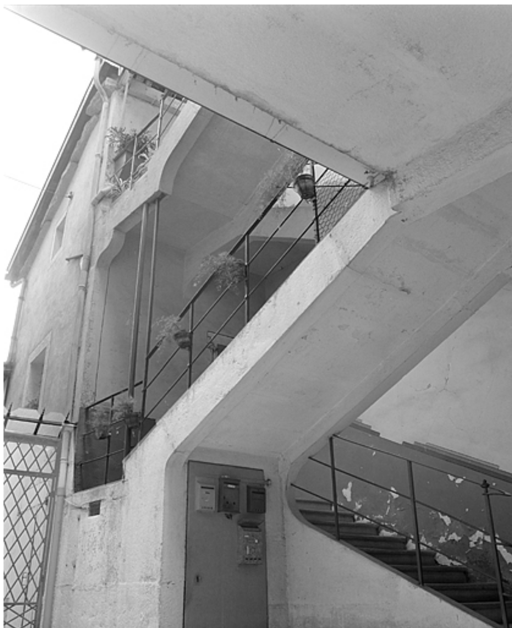
L'escalier ouvrant sur la cour.
