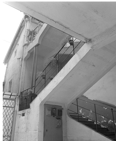
L'escalier ouvrant sur la cour. Phot. Yves Sancey IVR43_19853900300X
