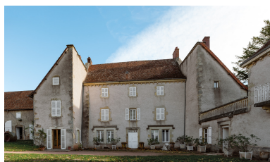
Le logis vu depuis l'ouest. Phot. Pierre-Marie Barbe-Richaud IVR26_20187100742NUC4A
