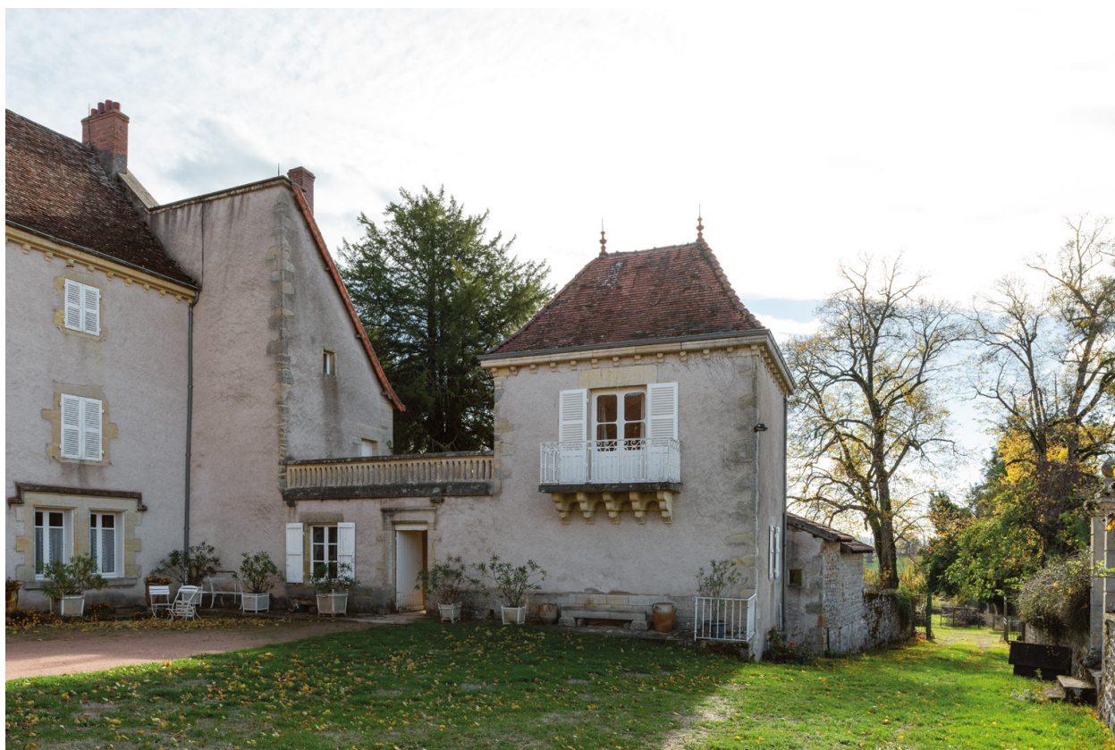
Aile sud du logis et pavillon ouest.
