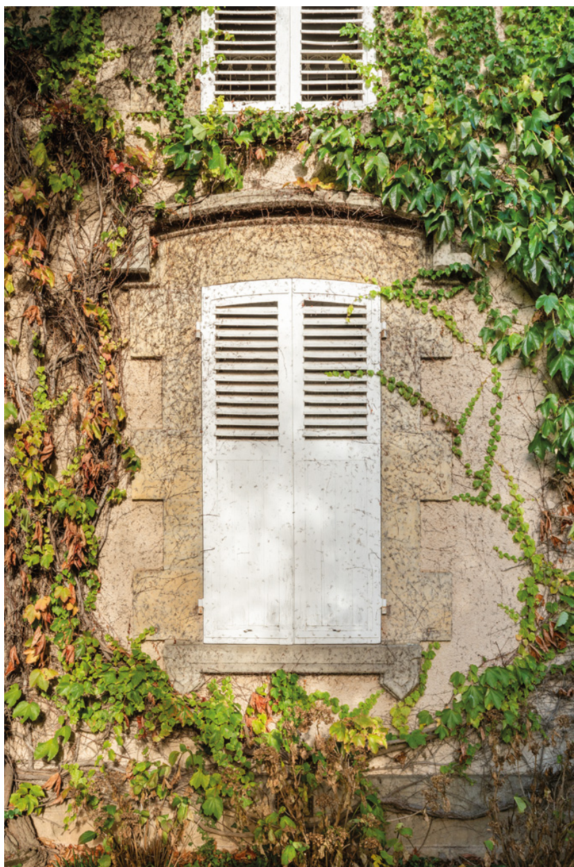
Logis. Fenêtre sur le pignon sud.
