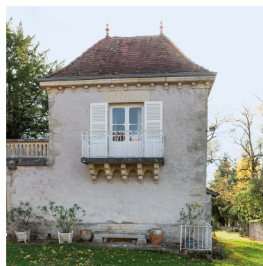
Façade nord du pavillon. Phot. Pierre-Marie Barbe-Richaud IVR26_20187100744NUC2A
