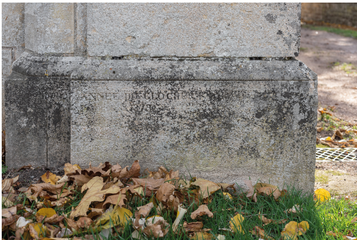
Base du pilier de la grille d'entrée.
