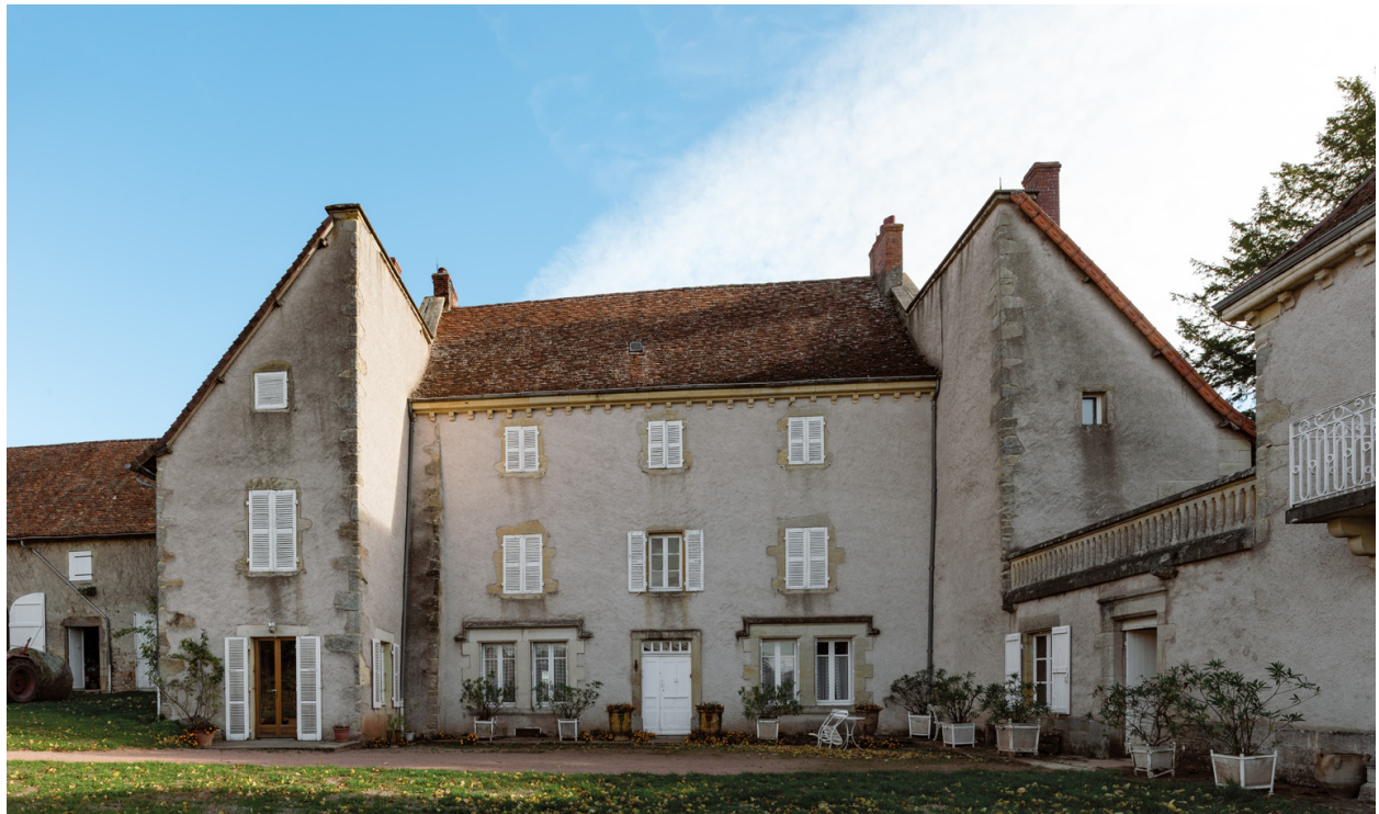
Le logis vu depuis l'ouest.
