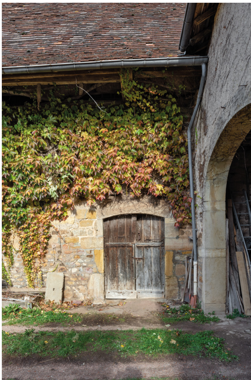
Porte d'étable du bâtiment nord.
