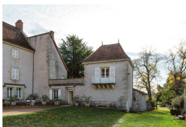
Aile sud du logis et pavillon ouest. Phot. Pierre-Marie Barbe-Richaud IVR26_20187100743NUC4A
