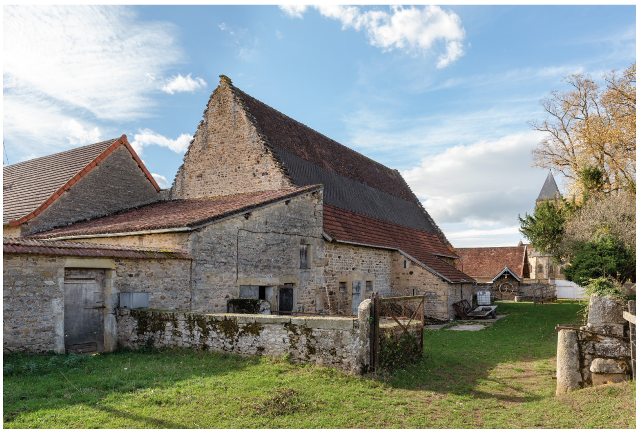
Façades postérieures des bâtiments agricoles.
