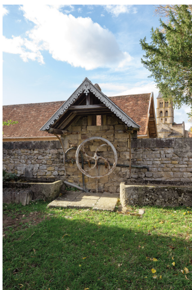
Abri de la pompe. Phot. Pierre-Marie Barbe-Richaud IVR26_20187100749NUC4A
