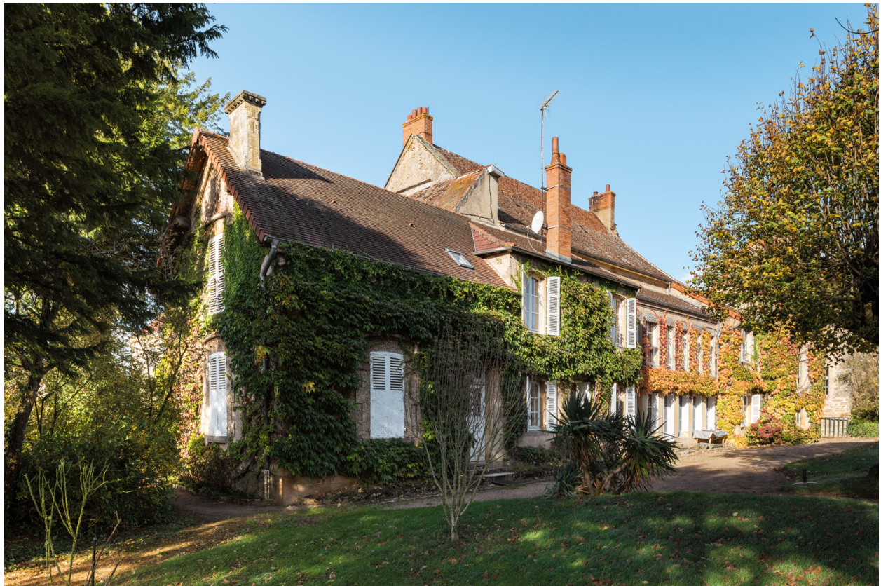
Le logis vu depuis le sud-ouest.
