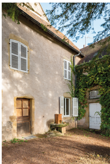
Façade de l'aile sud du logis. Phot. Pierre-Marie Barbe-Richaud IVR26_20187100745NUC4A
