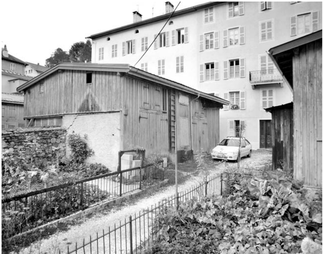
Bâtiment sud : bûcher et garage.
