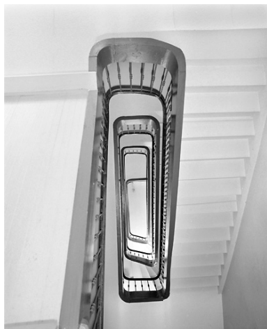
Cage d'escalier. Phot. Yves Sancey IVR43_20033900885X
