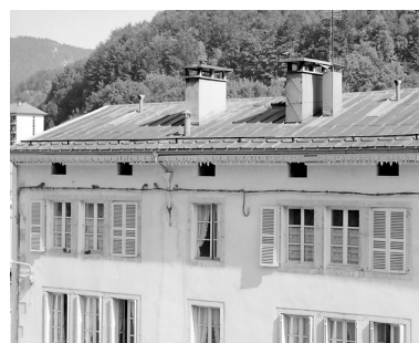
Façade antérieure : fenêtres jumelées aux étages. Phot. Yves Sancey IVR43_20033900879X
