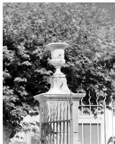
Clôture sur le quai Jobez : un vase. Phot. Yves Sancey IVR43_20033900889X
