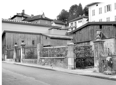
Clôture sur le quai Jobez. Phot. Yves Sancey IVR43_20033900890X
